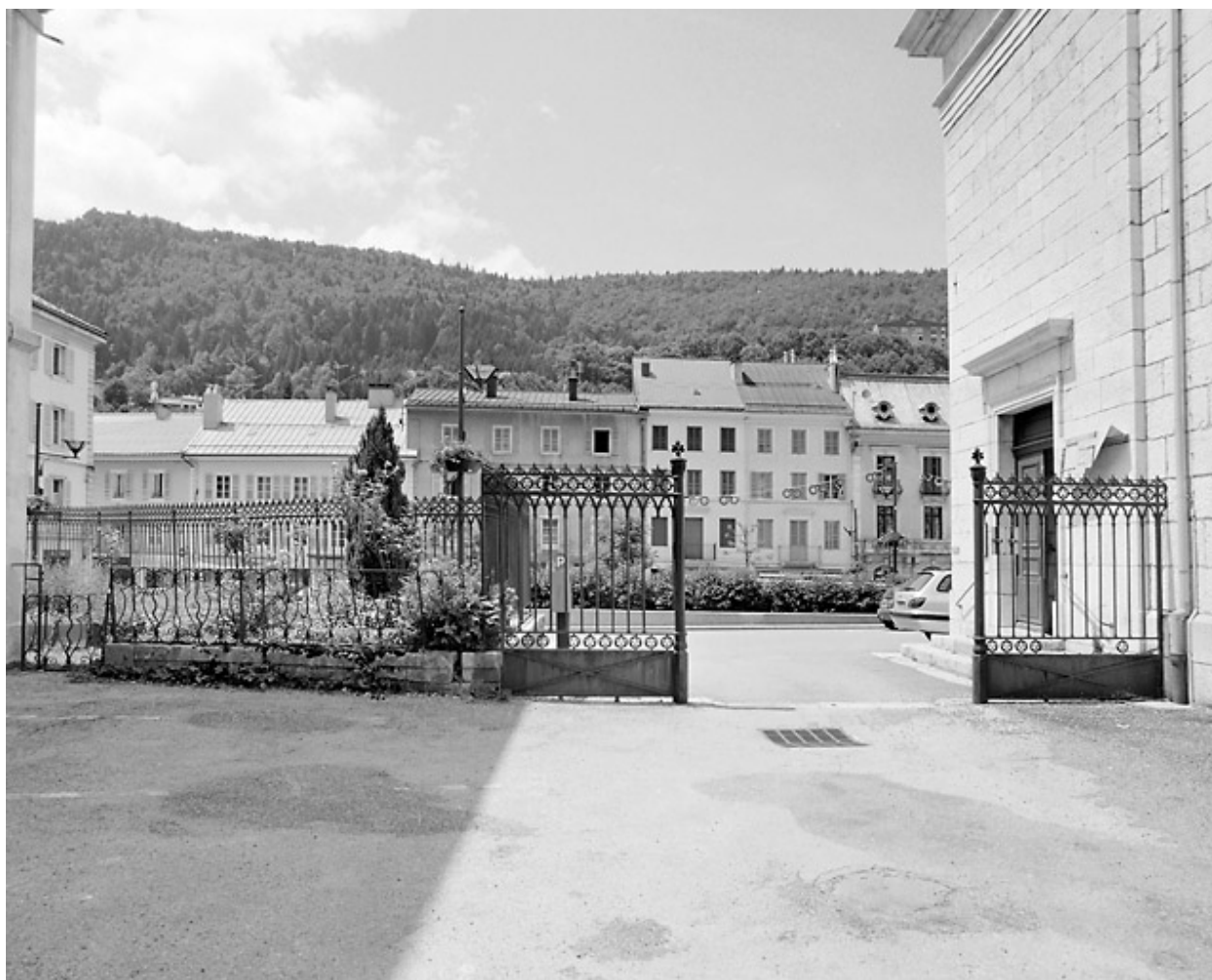
Vue d'ensemble, depuis la cour du presbytère.
