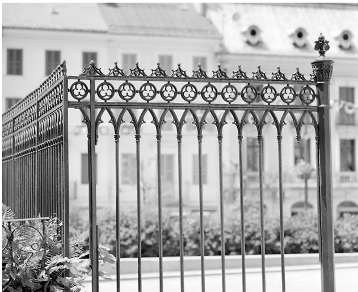
Travée fixe, côté presbytère : partie haute.
