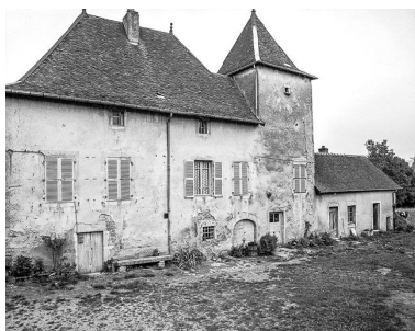
Demeure située au lieudit La Grange Rouge. Phot. Yves Sancey IVR43_19843900075X
