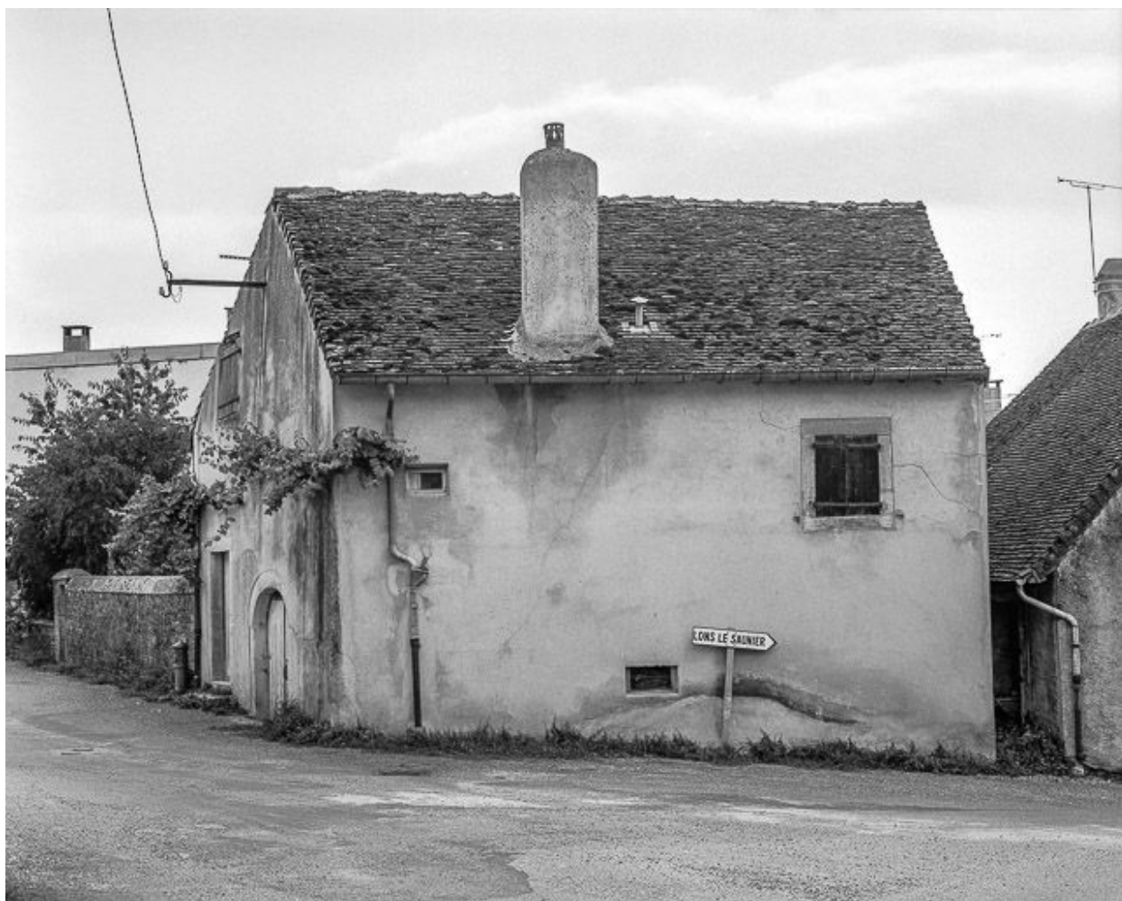
Maison de vigneron située chemin des Vannodes.
