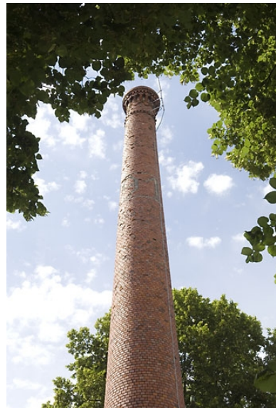
La cheminée. Phot. Jérôme Mongreville IVR43_20087000731NUC2A
