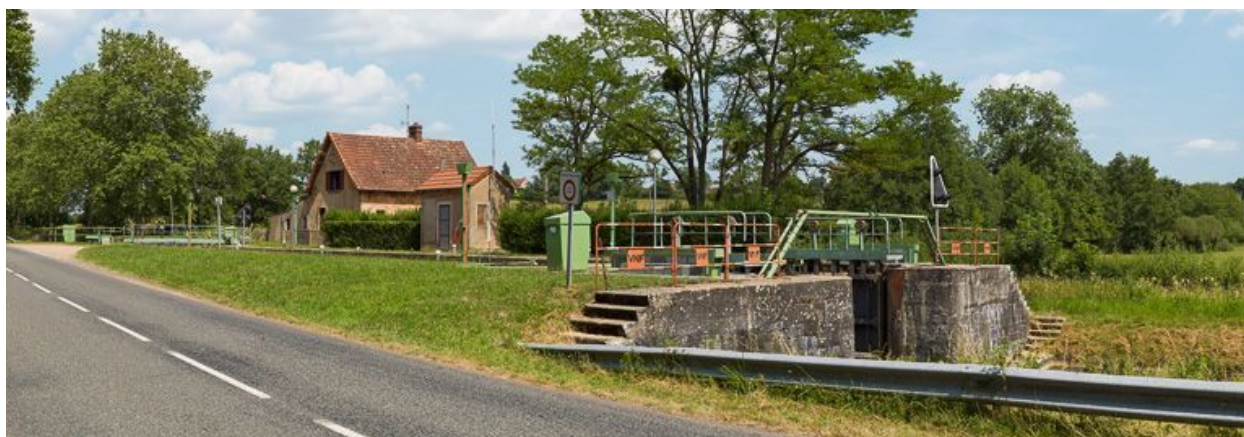
Vue d'ensemble, prise d'aval.
