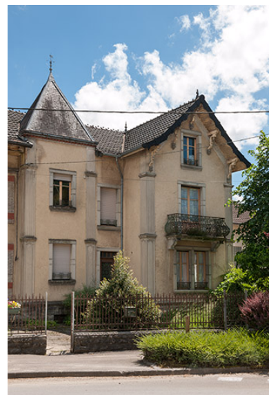
Le logement vu de trois quarts gauche. Phot. Jérôme Mongreville IVR43_20132500671NUC4A
