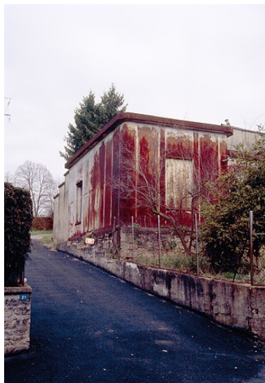
Vue d'ensemble. Phot. Yves Sancey IVR43_19943900828ZA
