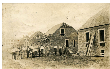
La cité ouvrière des Polognes en construction. Phot. Jérôme Mongreville IVR43_20067000203NUCA
