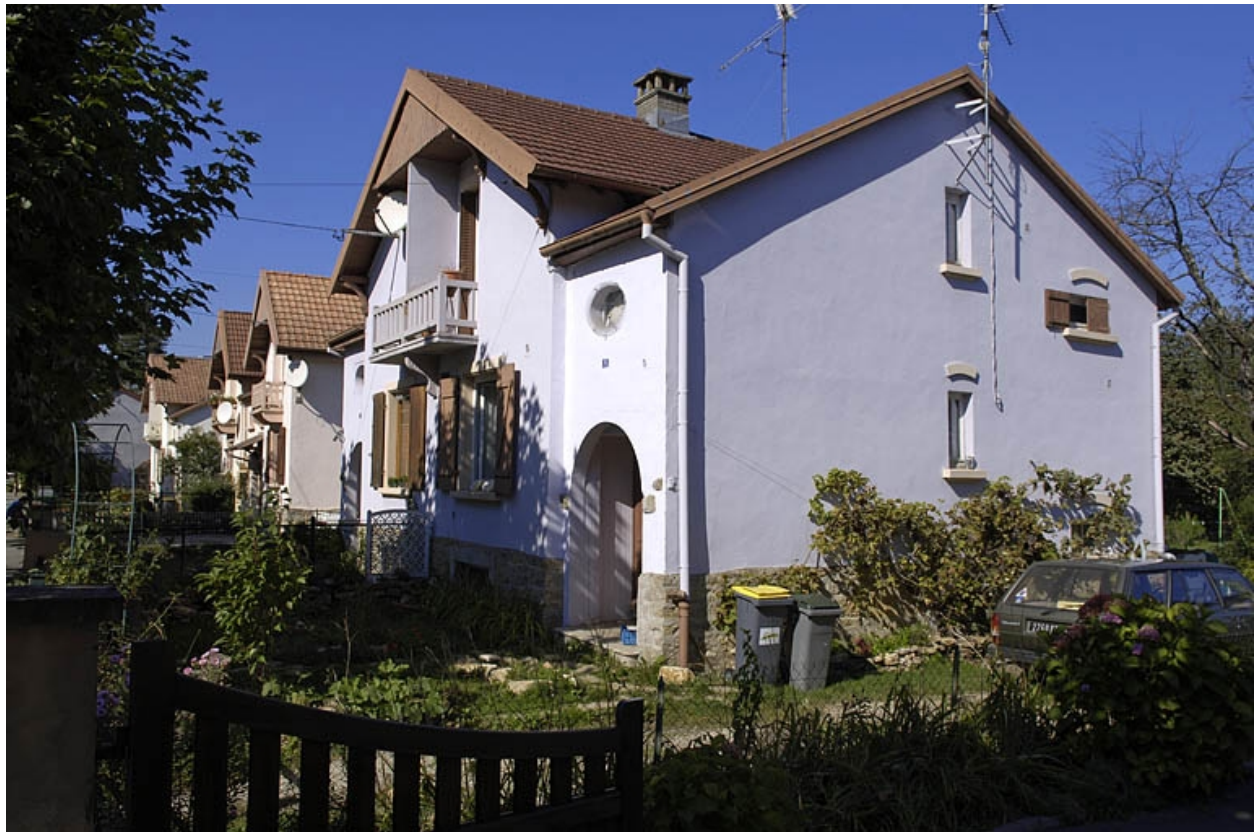
Façades postérieures de logements ouvriers doubles.
