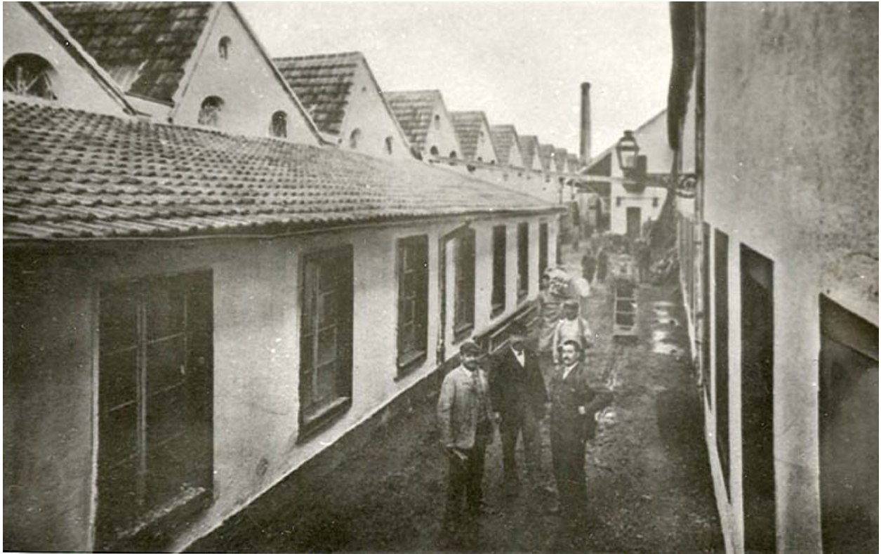
Ateliers de fabrication en rez-de-chaussée.
