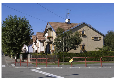
Logements ouvriers faubourg de Montbéliard.
