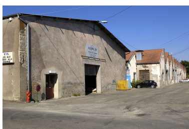
Façades sud du tissage. Phot. Jérôme Mongreville IVR43_20057000557NUCA
