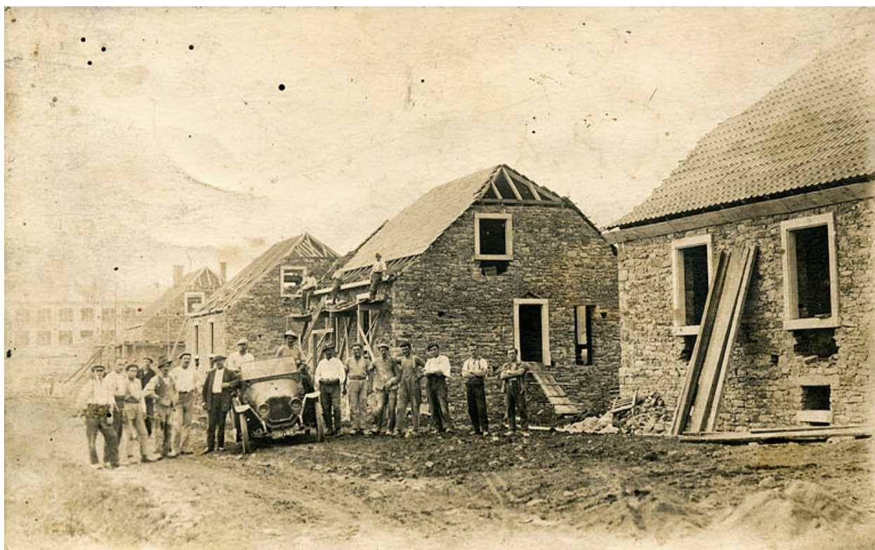
La cité ouvrière des Polognes en construction.
