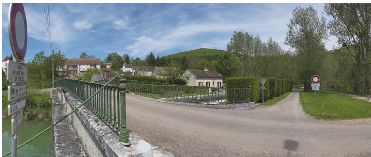
Pont vu d'aval.
