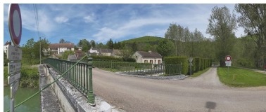
Pont vu d'aval. Phot. Thierry Kuntz IVR26_20122102441NUC4AQ
