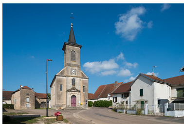
Vue d'ensemble. Phot. Jérôme Mongreville IVR43_20167001601NUC4A
