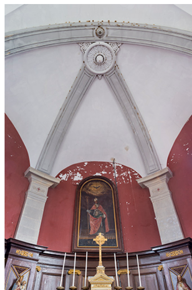
La voûte du chœur. Phot. Jérôme Mongreville IVR43_20167001634NUC4A
