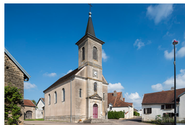
Vue latérale. Phot. Jérôme Mongreville IVR43_20167001602NUC4A
