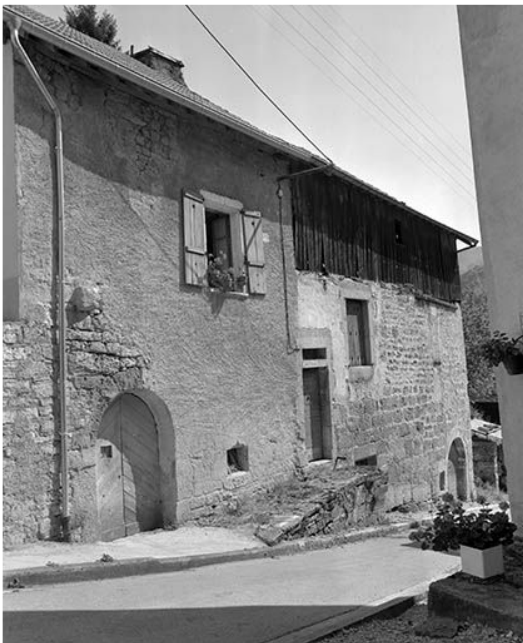
Maison située rue de Jaubourg, cadastrée 1971 AC 66.
