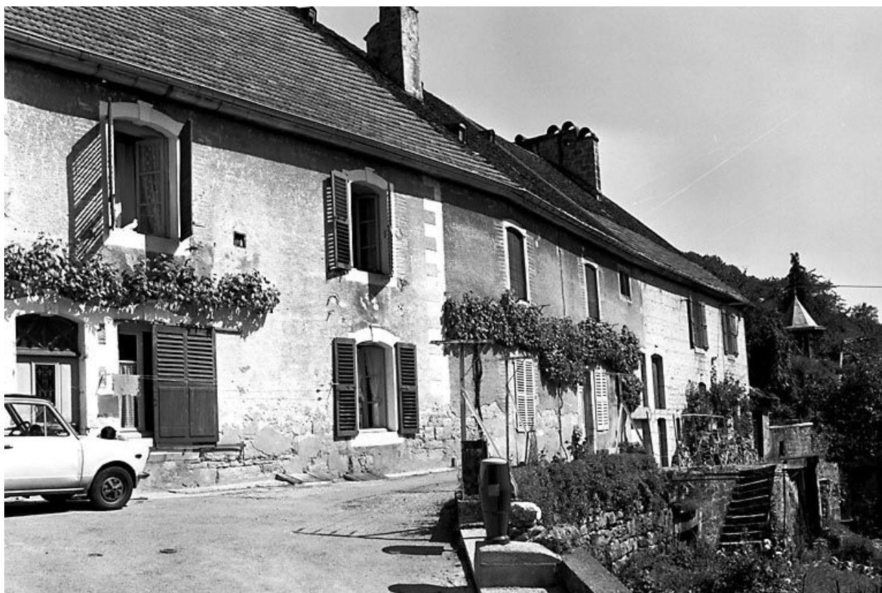
Maison située rue du Château.
