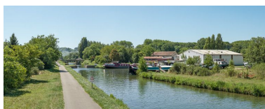
Le port de Mailly-la-Ville avec les hangars et l'écluse de garde. Phot. Pierre-Marie Barbe-Richaud IVR26_20138900146NUC4AQ
