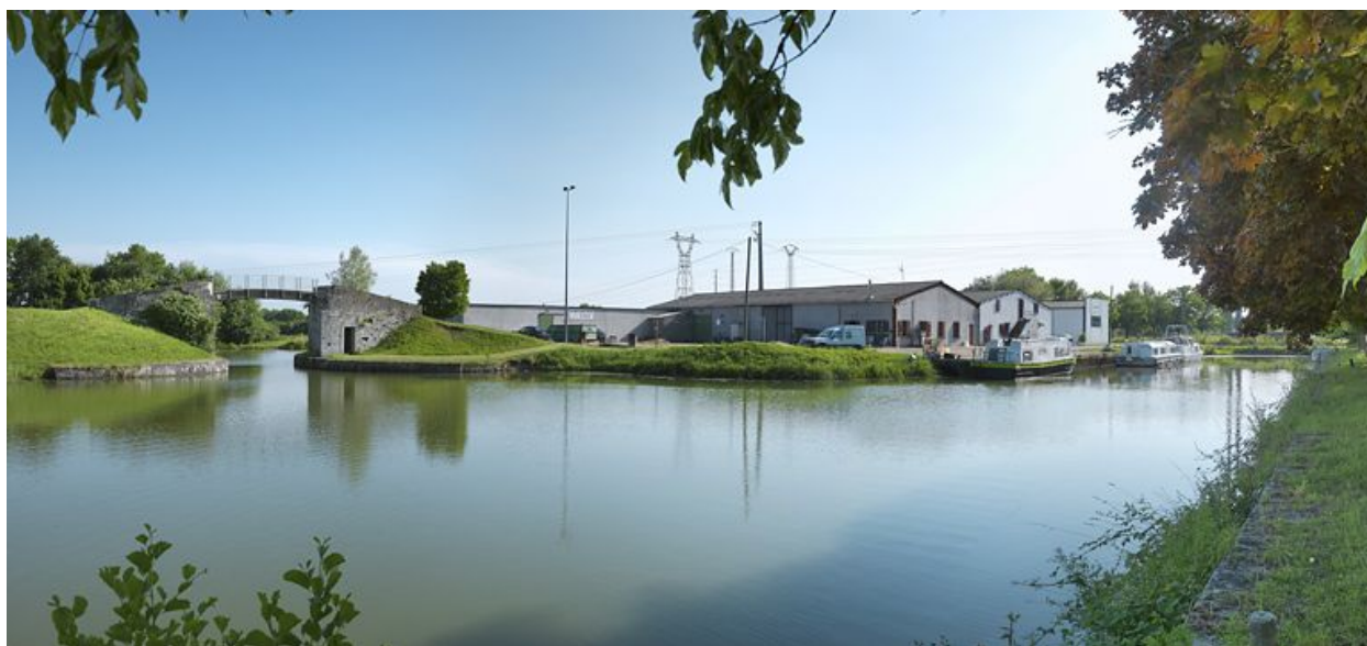
Vue d'ensemble du port de la Copine.
