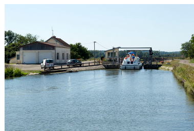
Depuis l'amont (nord), vue du site d'écluse. Phot. Sonia Dourlot IVR43_20157000734NUC2A
