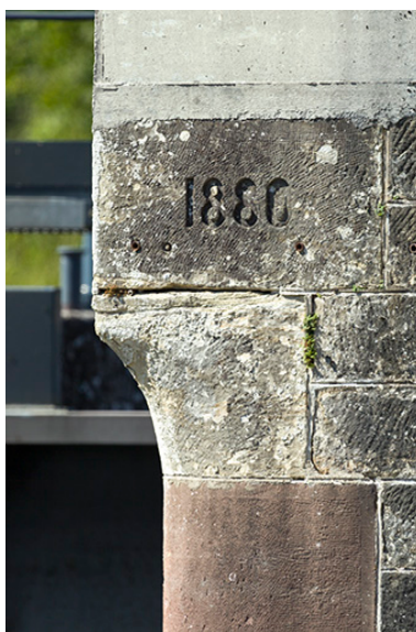
Date portée 1880 dans la maçonnerie (aval).
