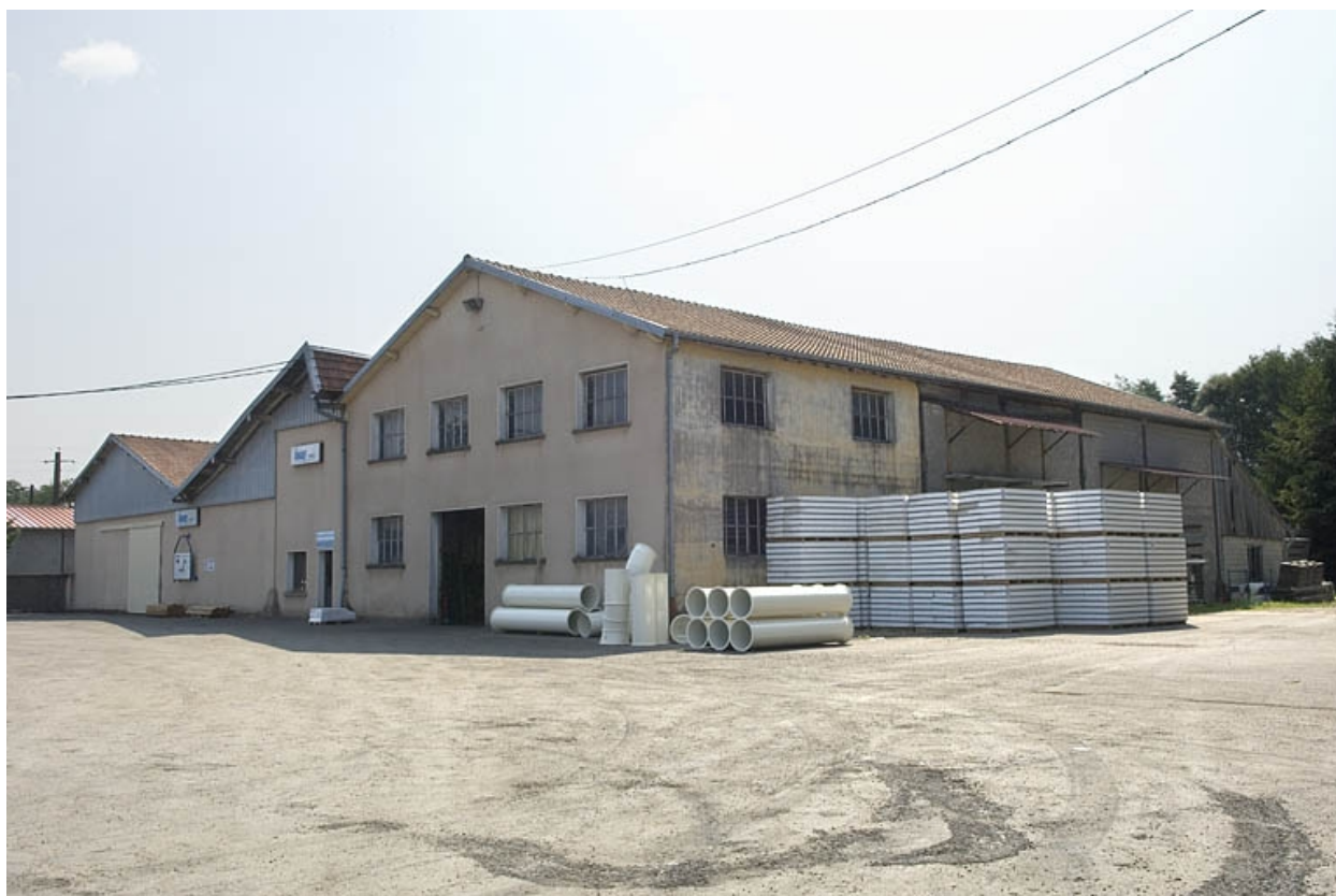
Magasin industriel (ancien four culée).
