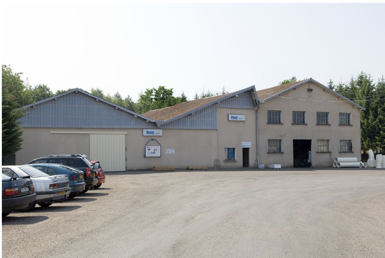
Magasin et entrepôt industriels depuis l'entrée.
