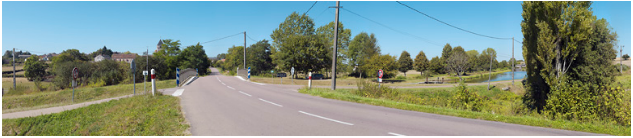
Pont sur l'écluse 03.
