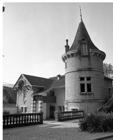
Façade antérieure des communs. Phot. Yves Sancey IVR43_19802501063X
