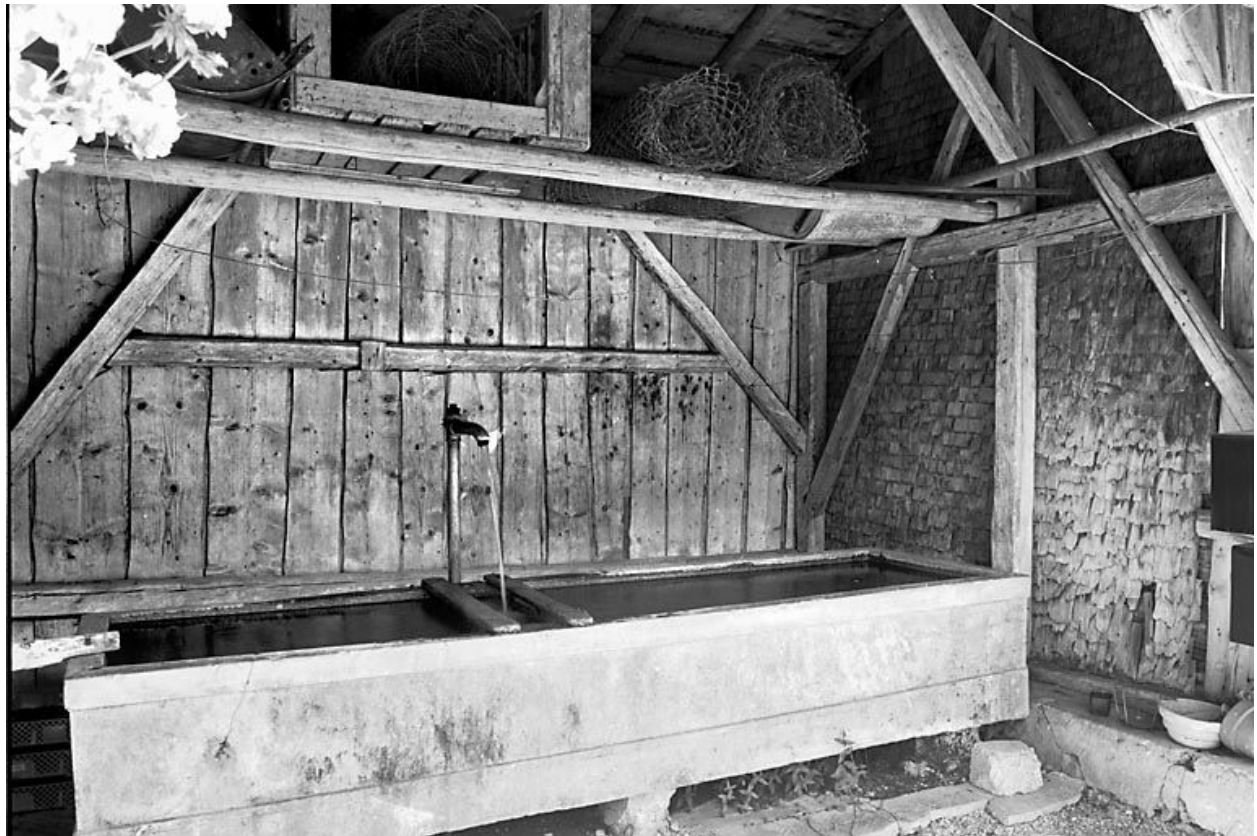
Vue du réservoir et de la charpente.
