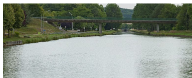
Vue du pont.
