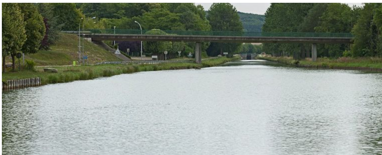
Vue du pont.
