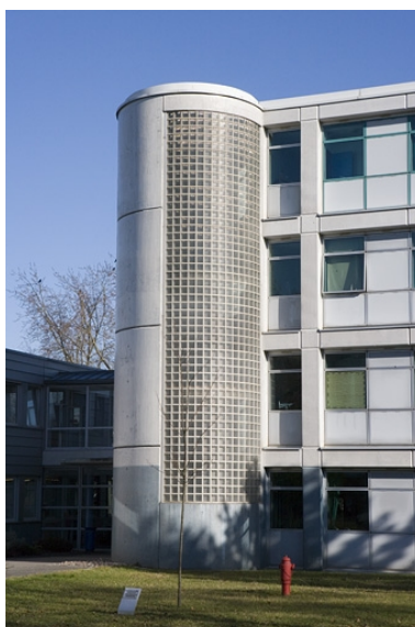
Bâtiment B. Détail de la travée d'escalier. Phot. Yves Sancey IVR43_20072501055NUCA
