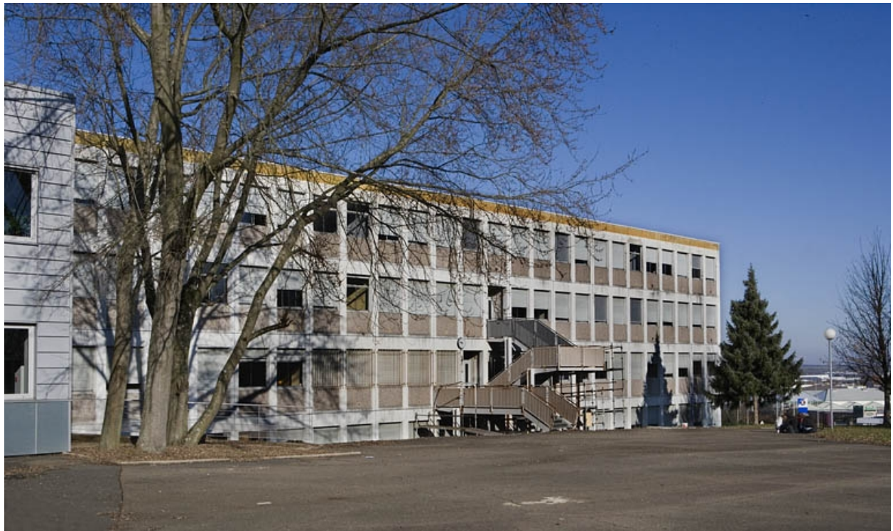
Bâtiment C. Vue de la façade antérieure.
