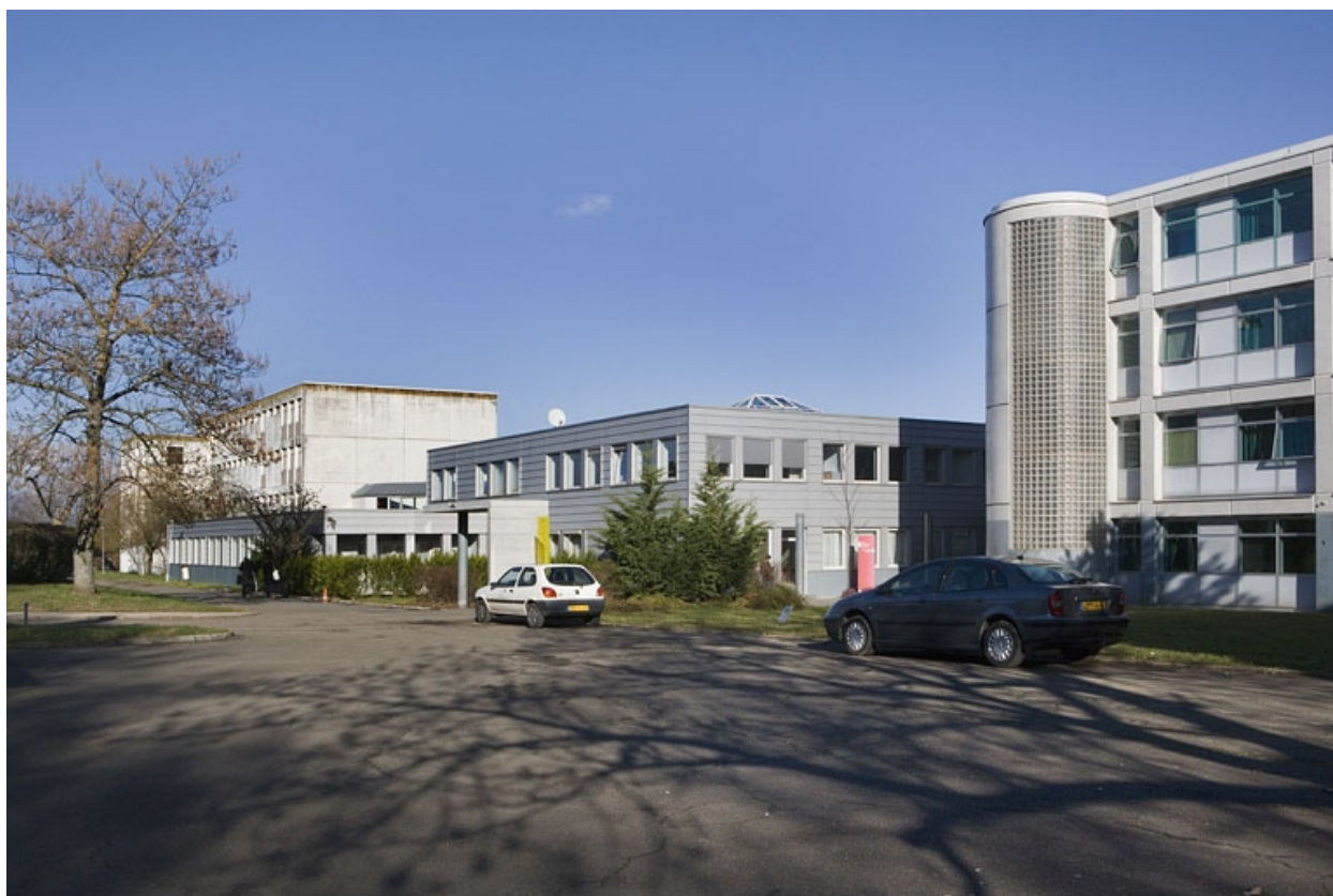
Vue d'ensemble depuis l'entrée principale.
