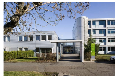
Vue de l'entrée principale. Phot. Yves Sancey IVR43_20072501054NUCA
