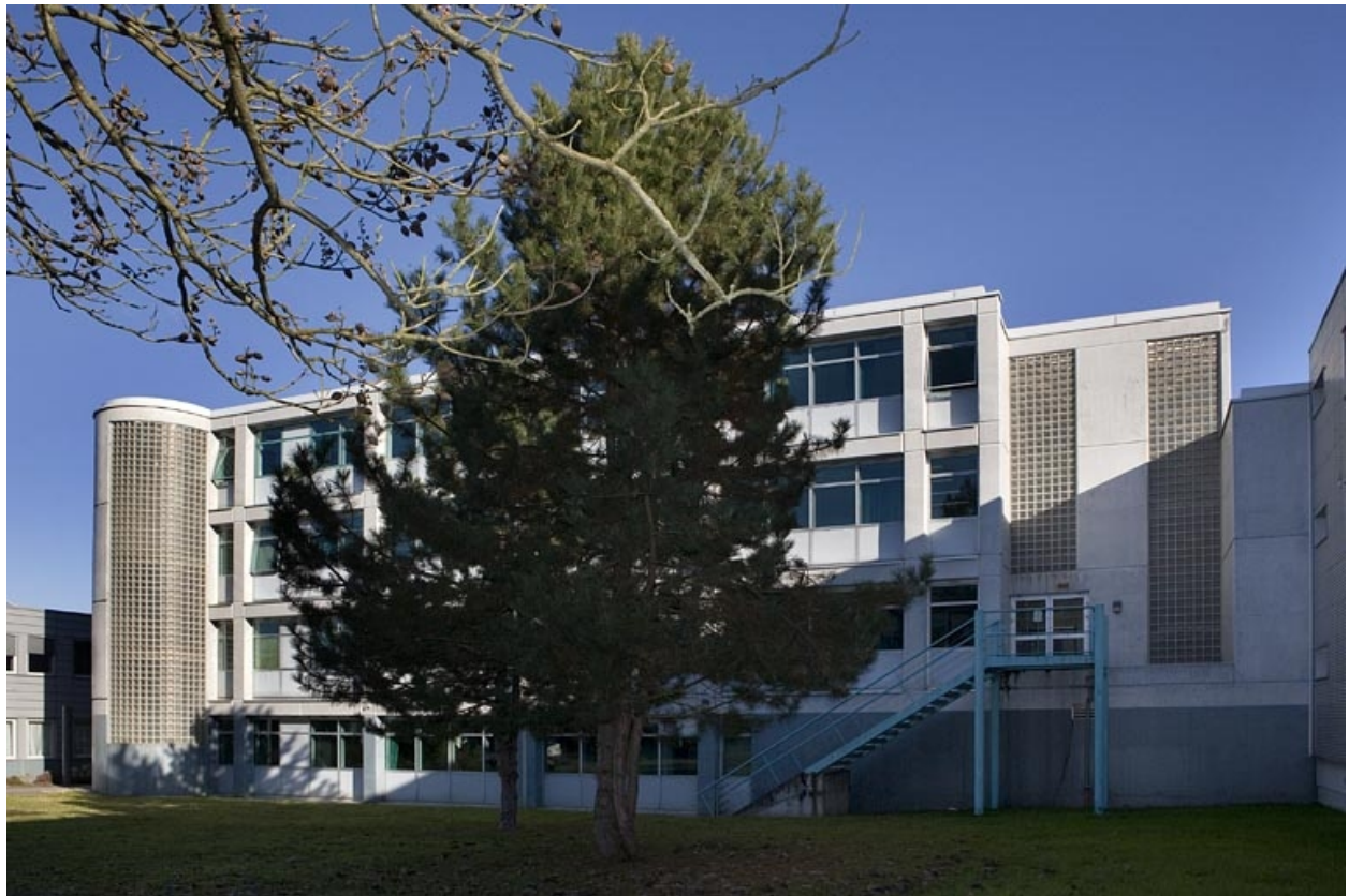
Bâtiment B. Vue de la façade antérieure.
