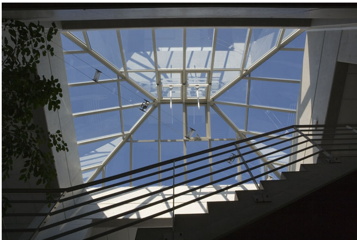
Bâtiment A. Détail de la verrière.
