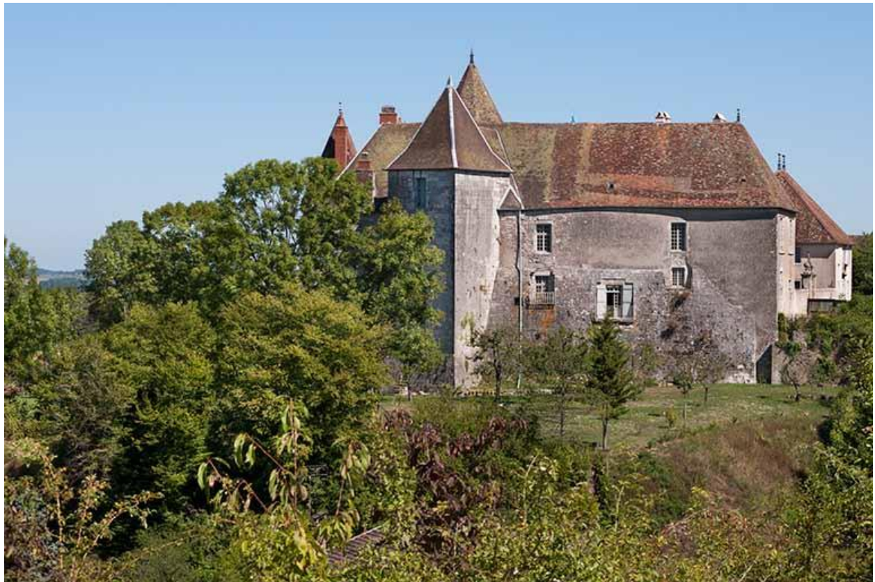
Vue ouest du château
