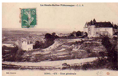
Vue générale ouest IVR43_20137000774NUC2A
