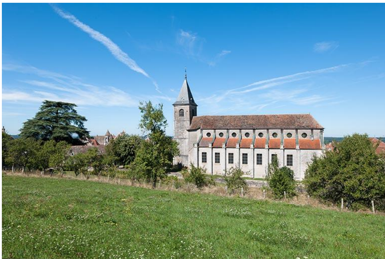
Vue générale sud de l'église
