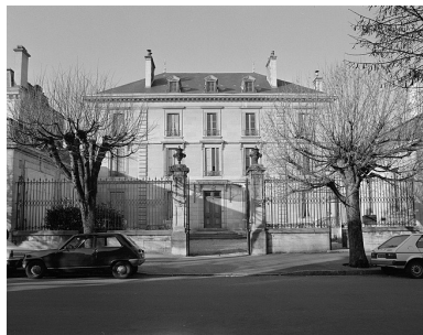
Vue d'ensemble. Phot. Yves Sancey IVR43_19833900665X
