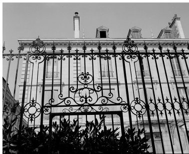
Détail grille de clôture. Phot. Yves Sancey IVR43_19833900183X
