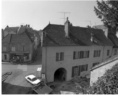
Façade postérieure en vue plongeante.
