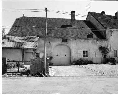
Façade antérieure. Phot. Bernard Lardière IVR43_19793900343X
