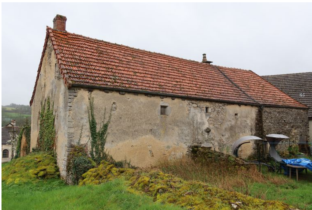
Vue du mur gouttereau nord de la ferme.
