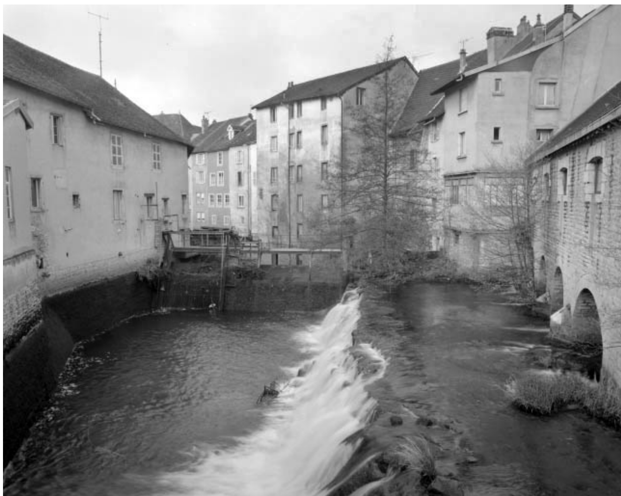
Remplissage du bassin de retenue.
