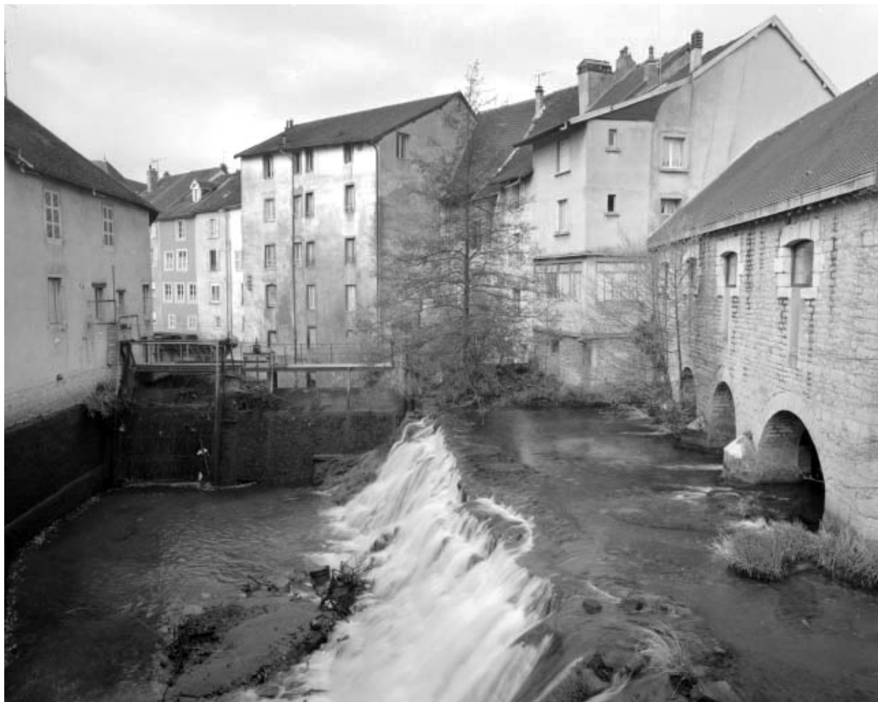
Le bassin de retenue vidé.
