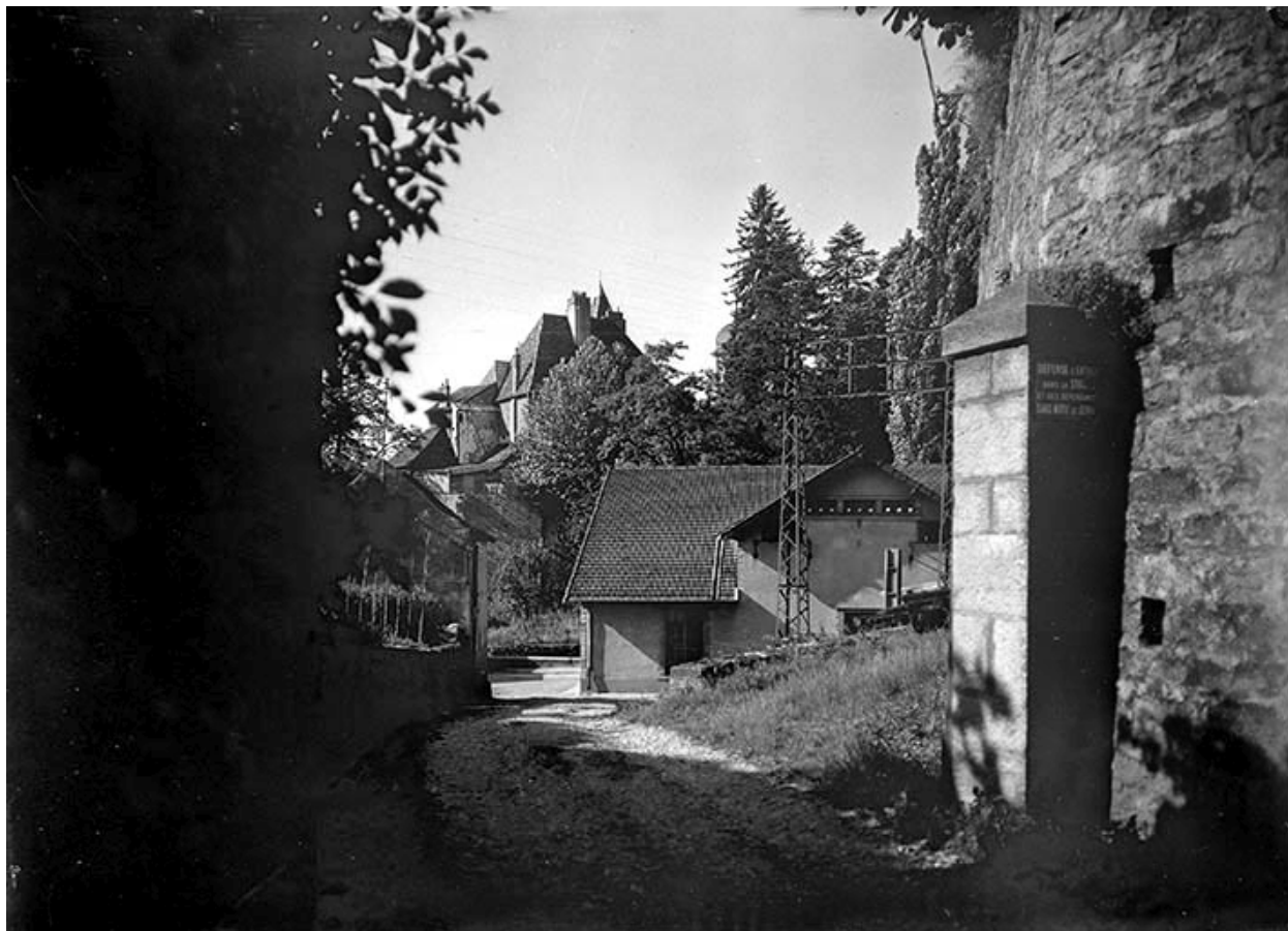
La centrale hydroélectrique depuis l'entrée.
