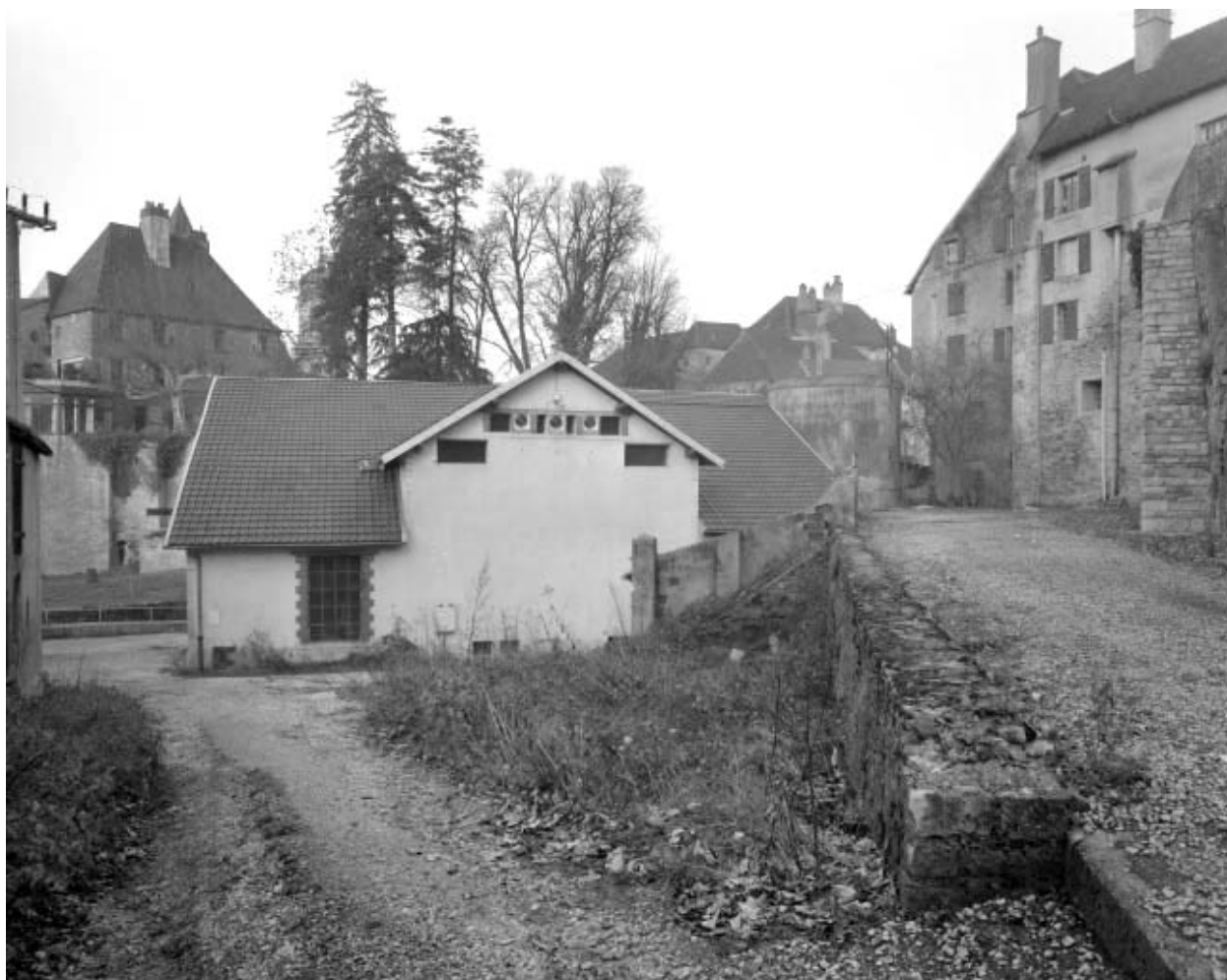
La centrale vue depuis l'entrée.
