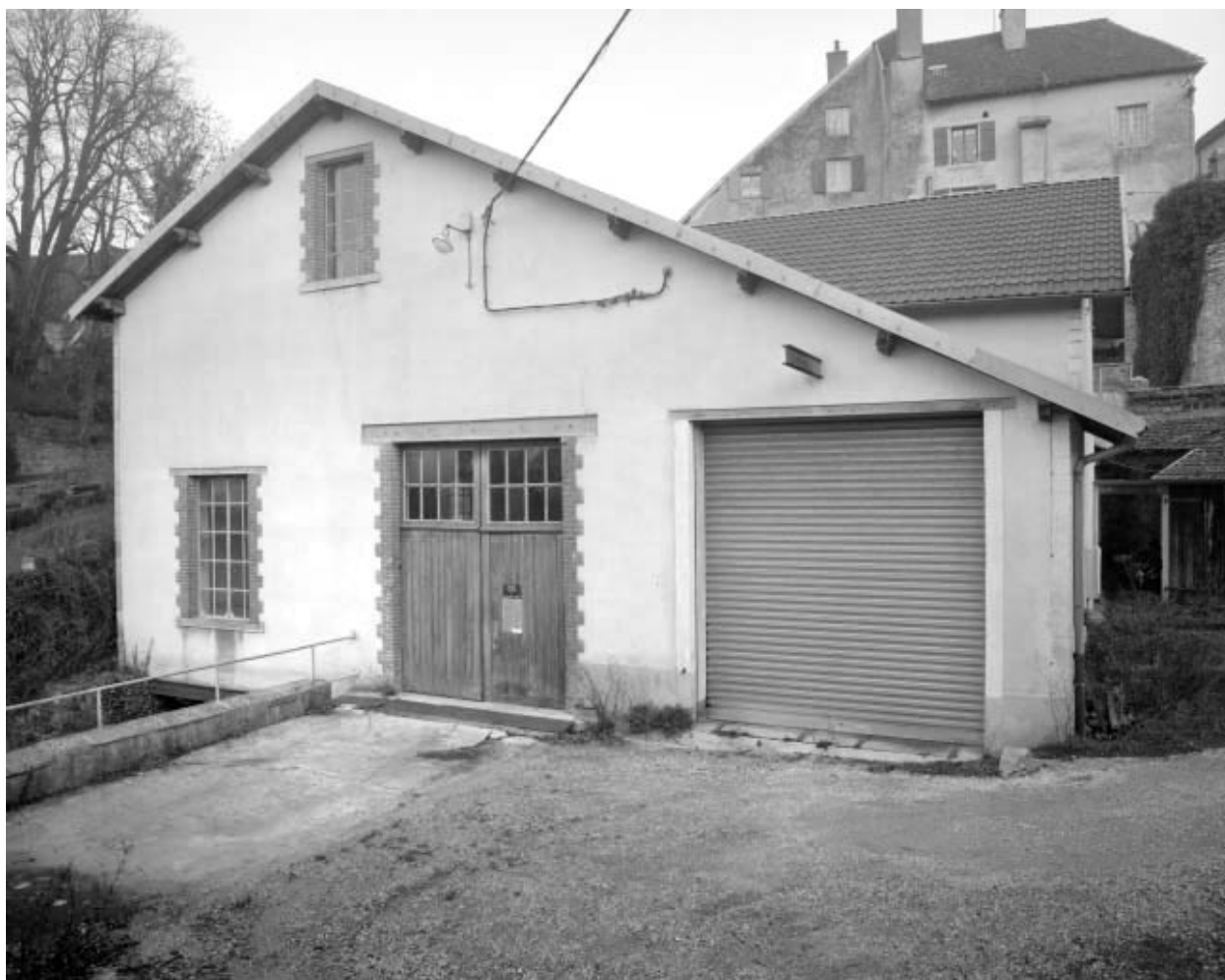
Façade antérieure depuis le sud-ouest.
