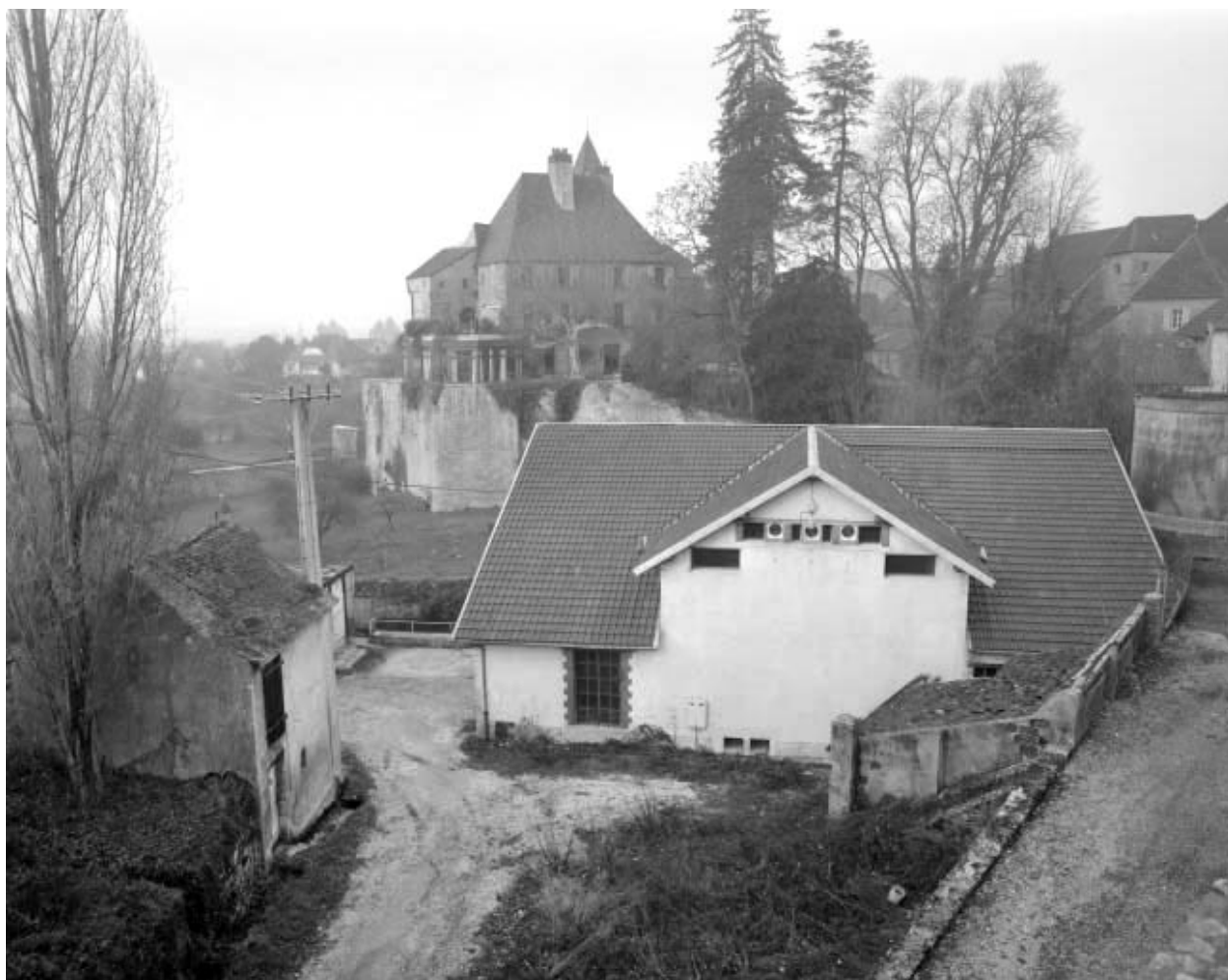
Vue plongeante sur la centrale.
