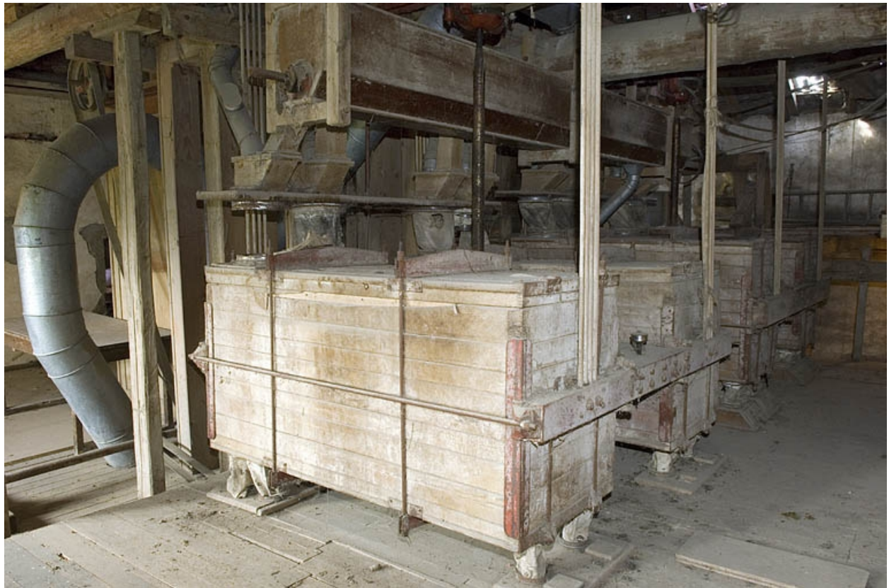
Vue d'ensemble des plansichters (3e étage).
