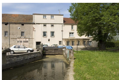
Bief d'amenée et façade antérieure. Phot. Jérôme Mongreville IVR43_20067000330NUCA
