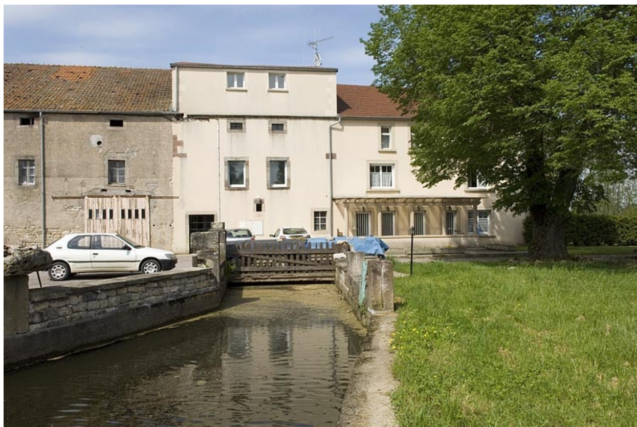
Bief d'amenée et façade antérieure.
