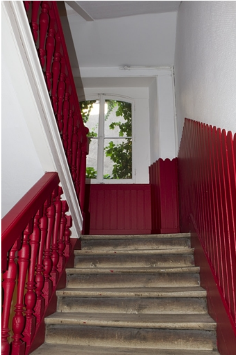
Logis principal : détail de l'escalier.
