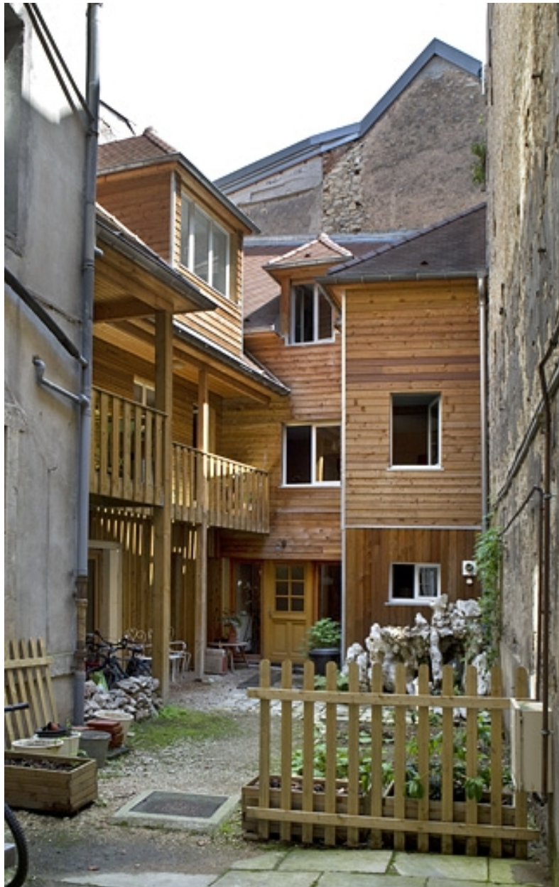
Logis secondaire : vue d'ensemble.
