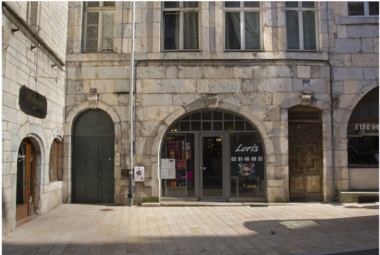
Façade antérieure : détail du rez-de-chaussée.
