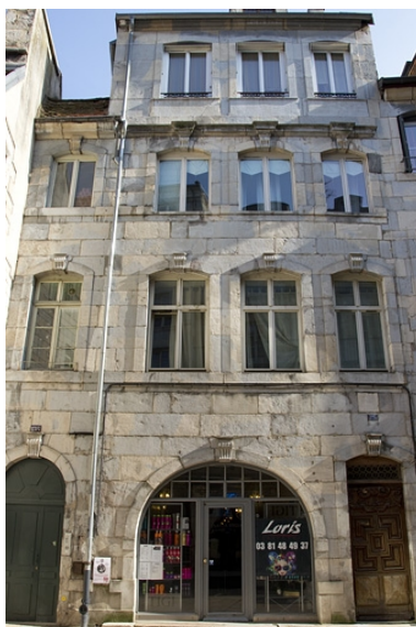
Vue d'ensemble de la façade antérieure.
