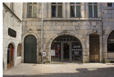
Façade antérieure : détail du rez-de-chaussée.
