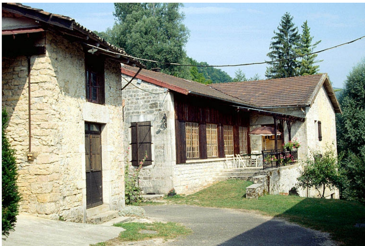
Façade postérieure du moulin et bâtiment (B).
