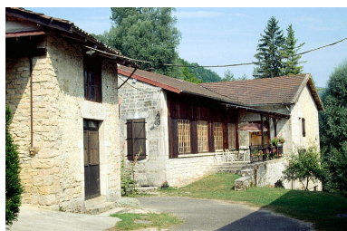
Façade postérieure du moulin et bâtiment (B). Phot. Laurent Poupard IVR43_19923901216ZA
