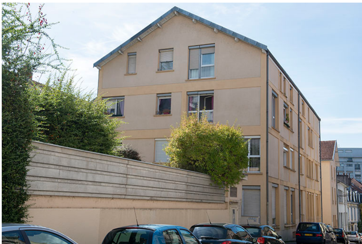
Vue depuis le nord.
