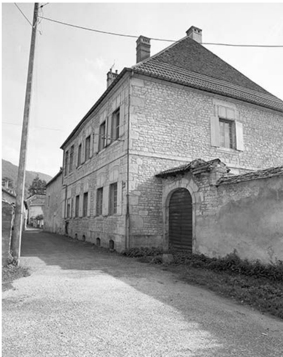
Façade sur la rue Saint-Antoine.
