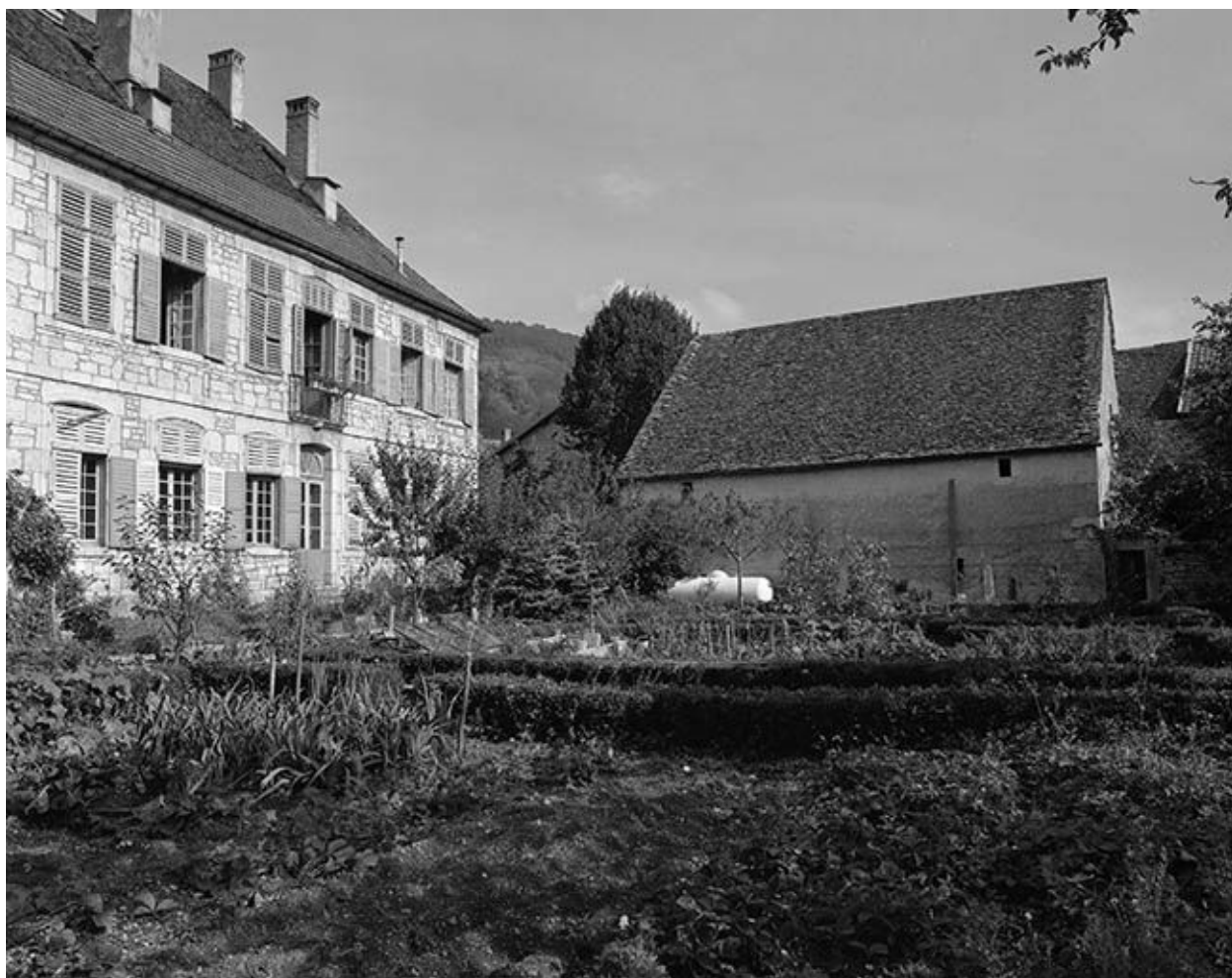
Vue d'ensemble depuis le jardin.
