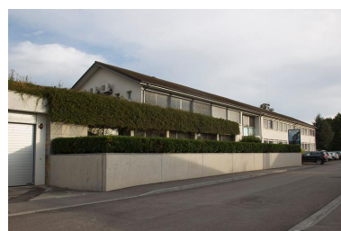
Extension ouest : façade sur la rue de la 1ère Armée. Phot. Yves Sancey IVR43_20122501743NUC2A
