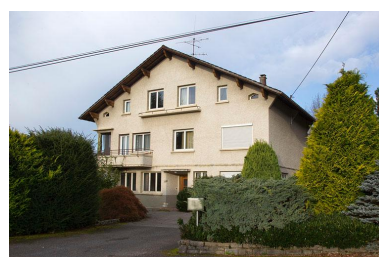
Logement patronal, de trois quarts droite. Phot. Yves Sancey IVR43_20122501760NUC2A
