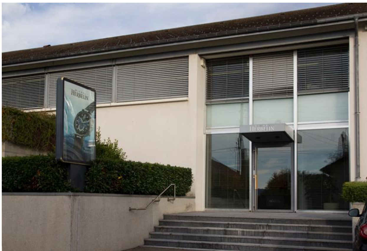
Entrée de l'usine.
