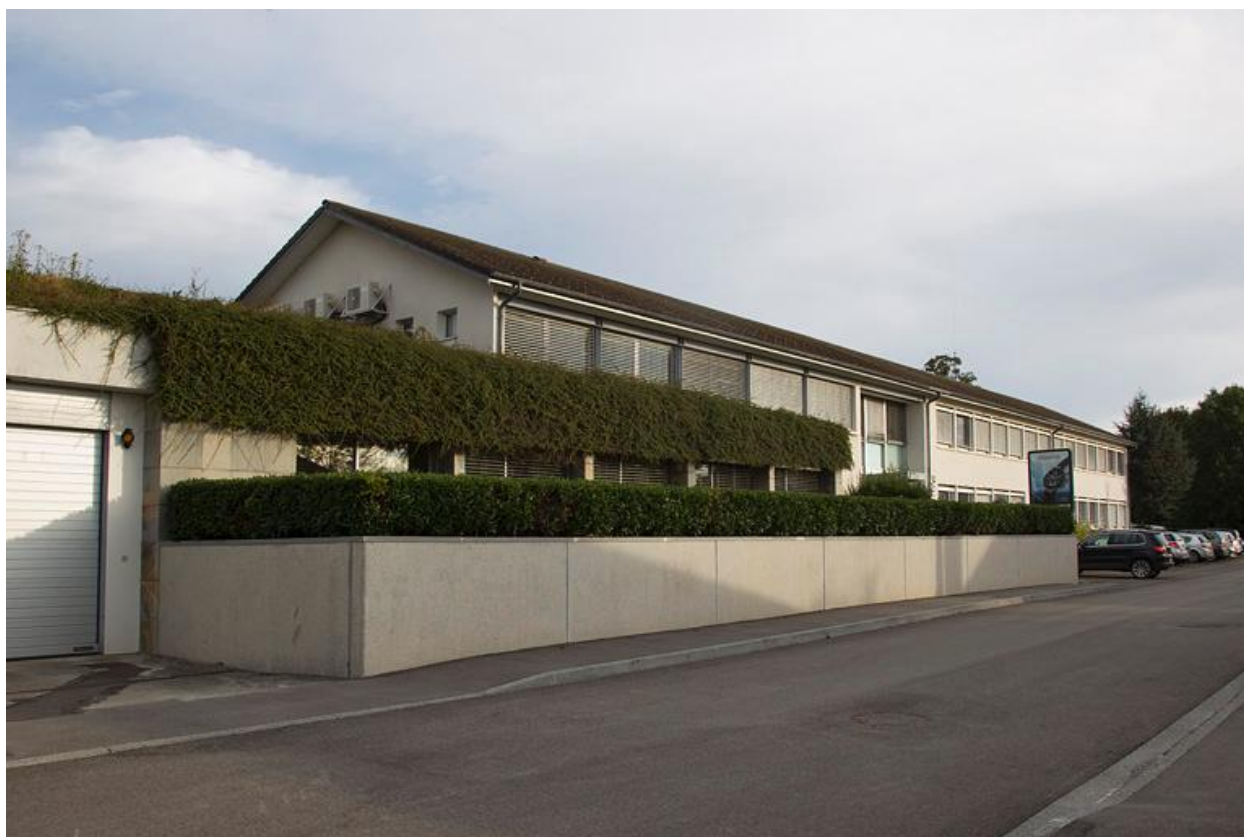
Extension ouest : façade sur la rue de la 1ère Armée.
