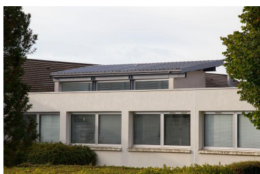
Lanterneau sur l'extension nord. Phot. Yves Sancey IVR43_20122501750NUC2A
