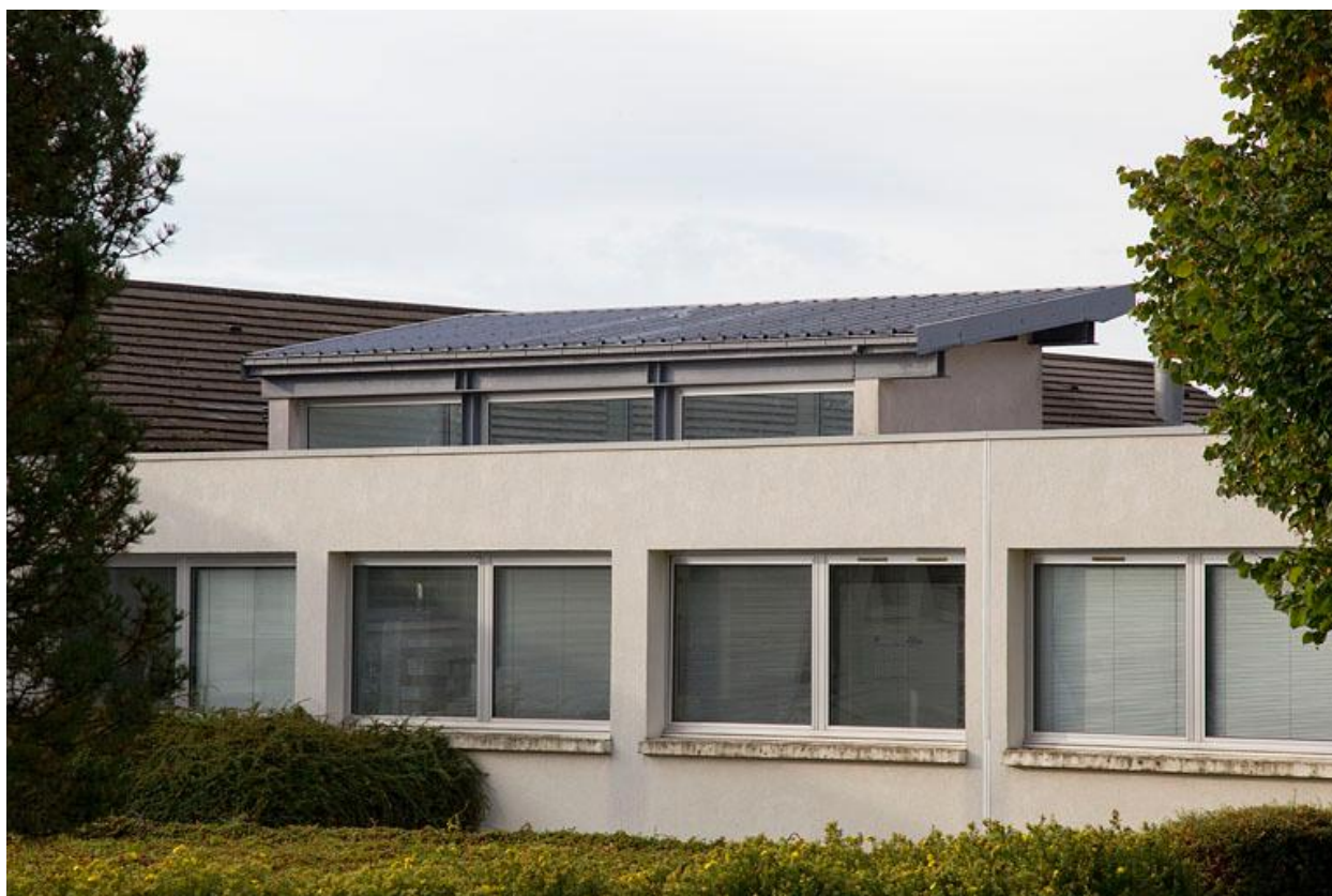
Lanterneau sur l'extension nord.
