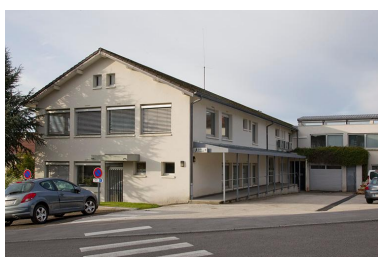
Bâtiment d'origine : façades latérale droite et postérieure. Phot. Yves Sancey IVR43_20122501747NUC2A
