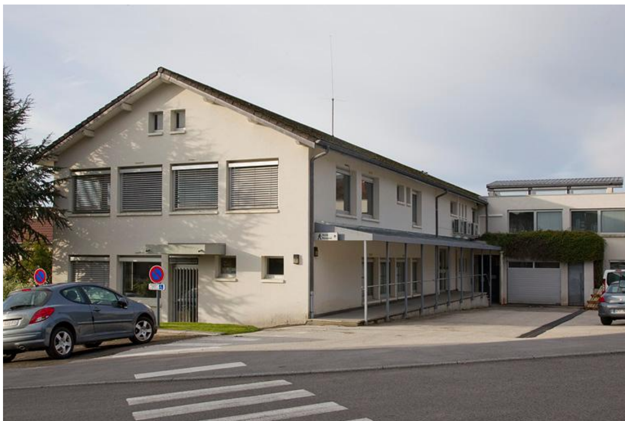
Bâtiment d'origine : façades latérale droite et postérieure.
