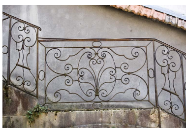
Détail de la rampe en fer forgé de l'escalier isolé dans la deuxième cour.
