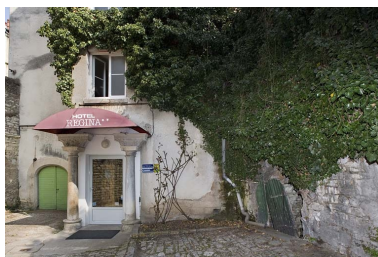
Vue d'ensemble éloignée du rez- de-chaussée du logis secondaire au fond de la deuxième cour.
