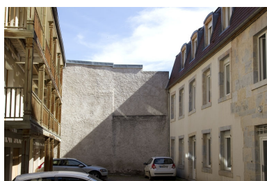
Vue d'ensemble de la deuxième cour.
