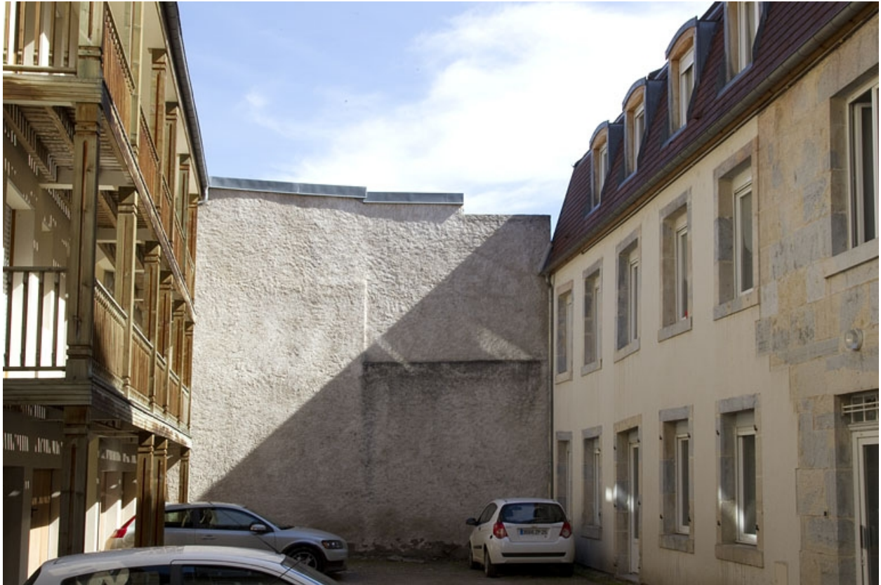
Vue d'ensemble de la deuxième cour.
