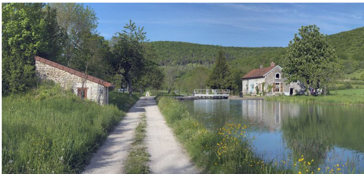
Vue d'ensemble de l'amont de la maison éclusière.
