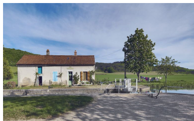
Maison éclusière de face. Phot. Thierry Kuntz IVR26_20122102424NUC4A
