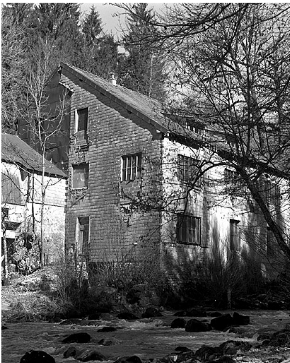
Ancien atelier de fabrication depuis le sud.
