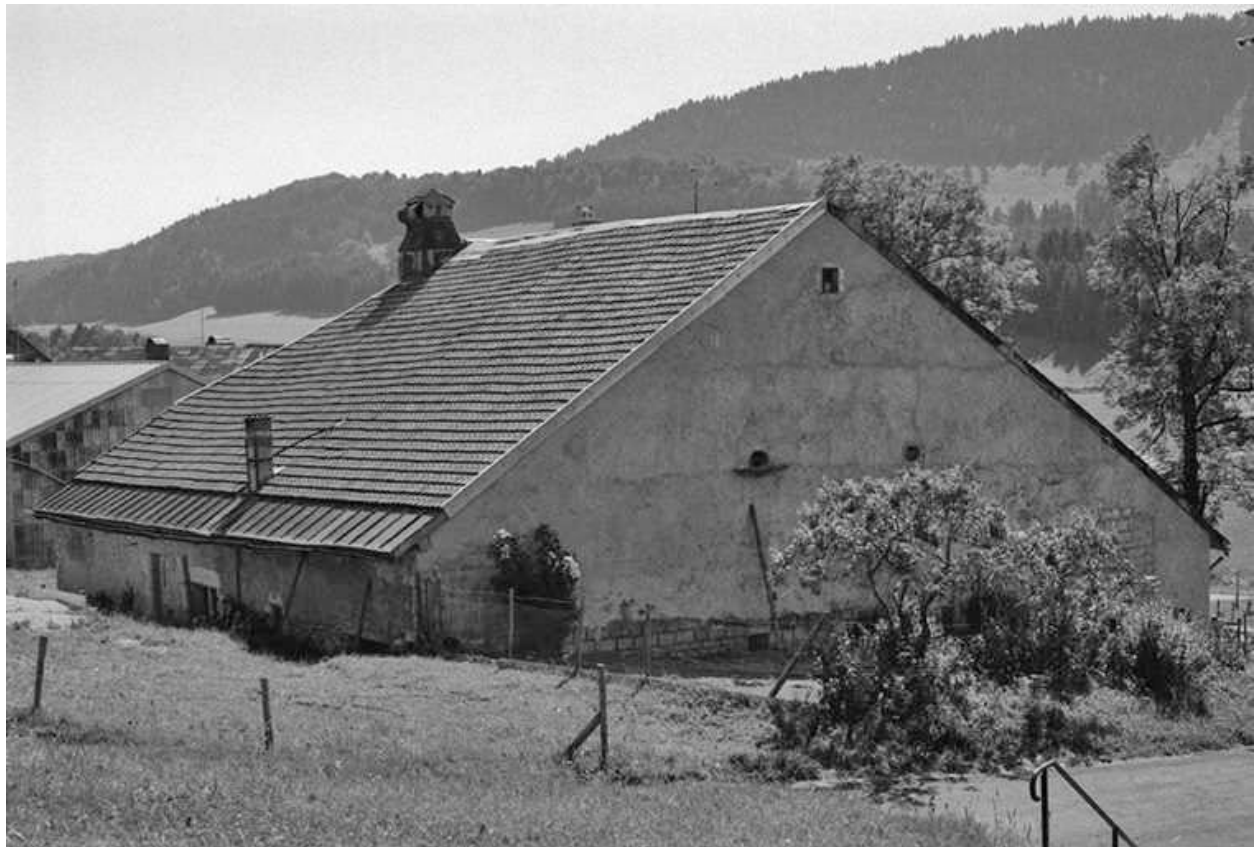
Façades postérieure et latérale gauche.
