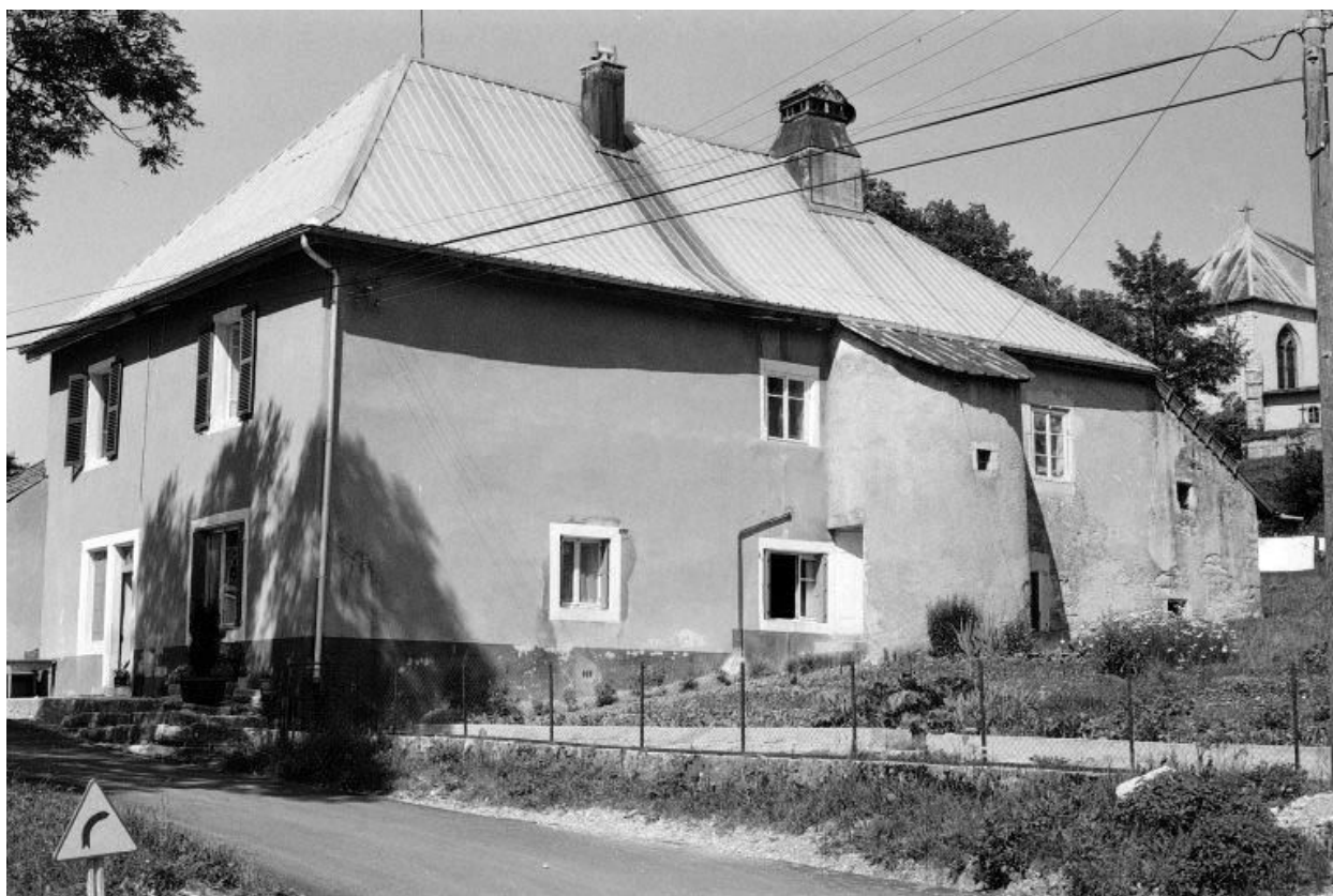
Façades antérieure et latérale droite.
