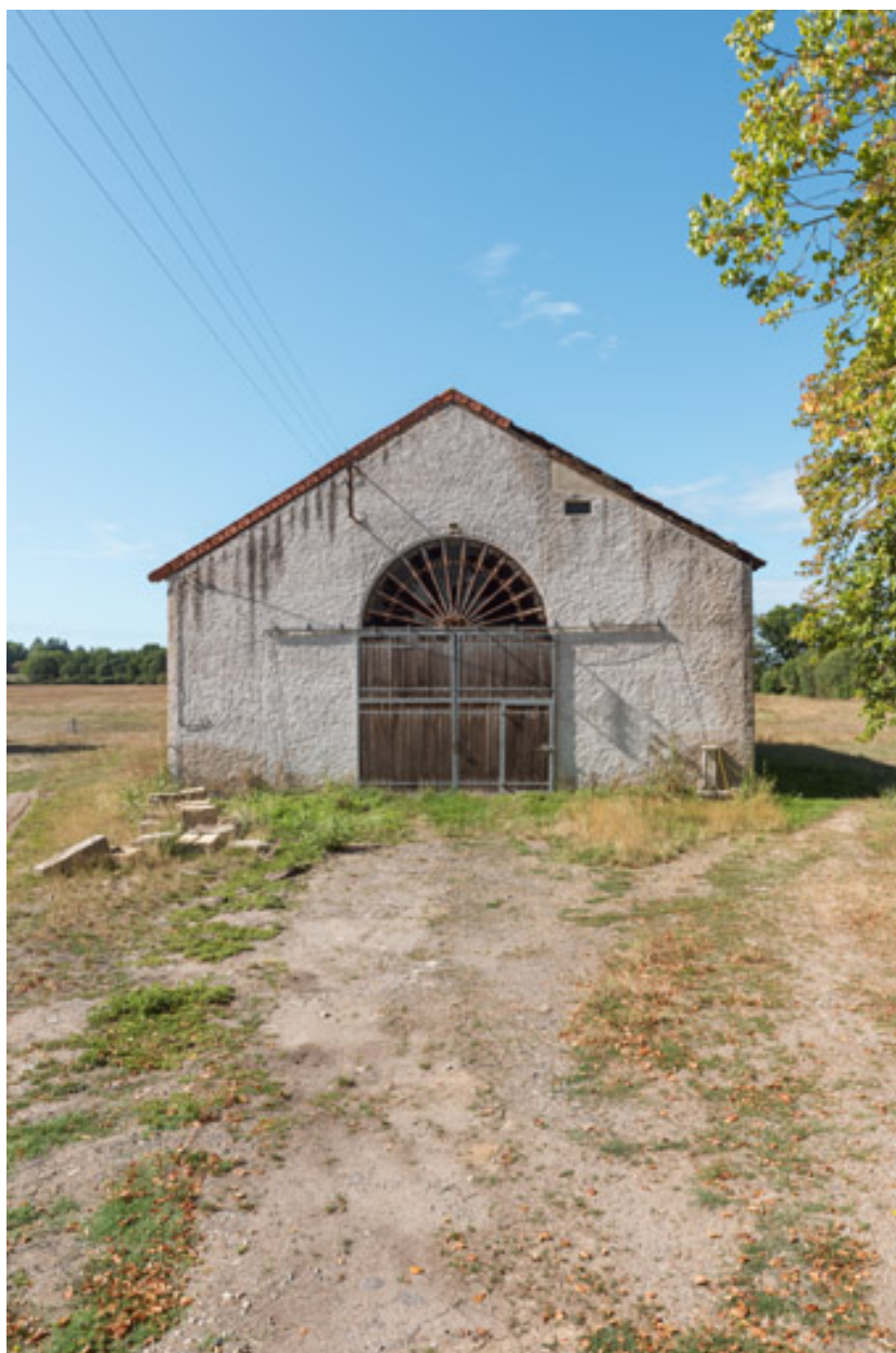
Vue de face (vue rapprochée).
