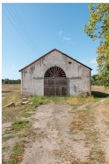
Vue de face (vue rapprochée).
