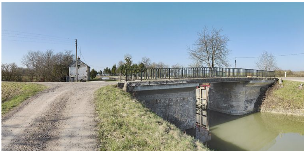
Le pont vu d'aval.
