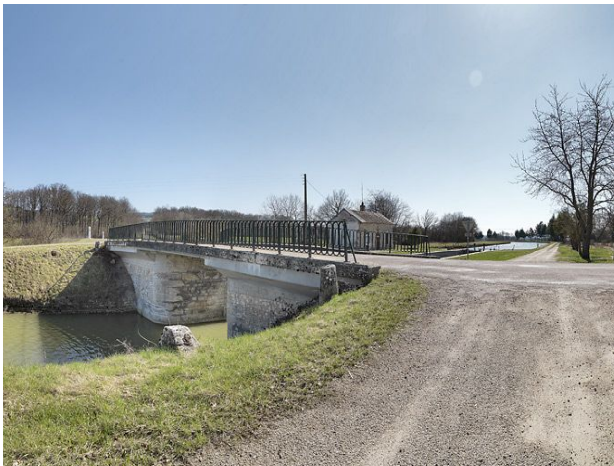
Le pont vu d'aval.
