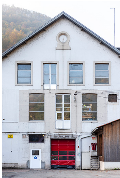
Atelier de fabrication (ancienne pointerie) : façade antérieure.
