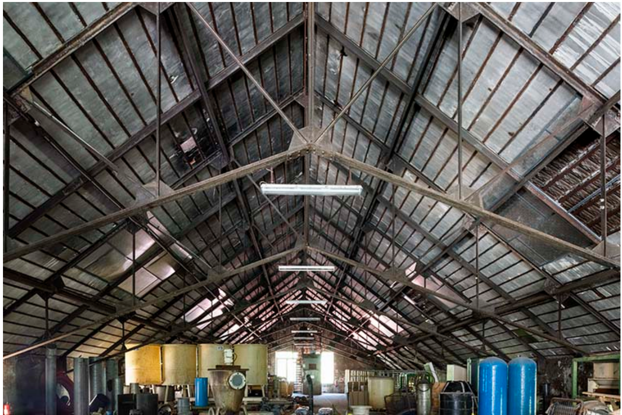
Atelier de fabrication (ancienne tréfilerie) : charpente métallique.
