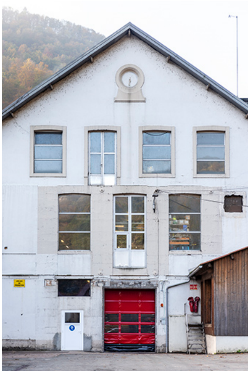
Atelier de fabrication (ancienne pointerie) : façade antérieure.
