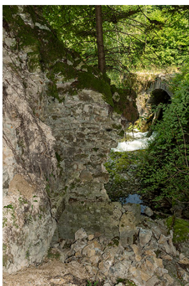
Ruines de la scierie Vadam, sur la rive droite. Phot. Sonia Dourlot IVR43_20192501531NUC4A
