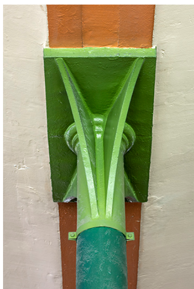
Atelier de fabrication (ancienne pointerie) : chapiteau d'un poteau en fonte. Phot. Sonia Dourlot IVR43_20192500588NUC4A
