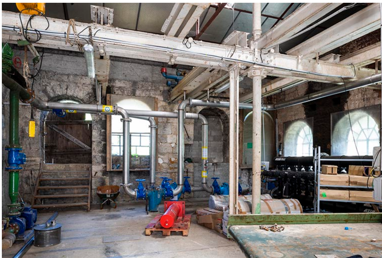
Bâtiment d'eau (actuellement station de pompage) : intérieur.
