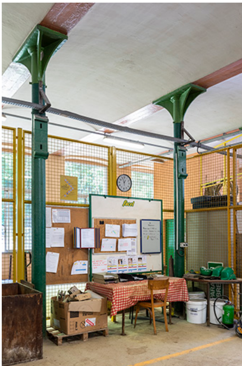
Atelier de fabrication (ancienne pointerie) : poteaux en fonte et voûtaines en briques plâtrées.
