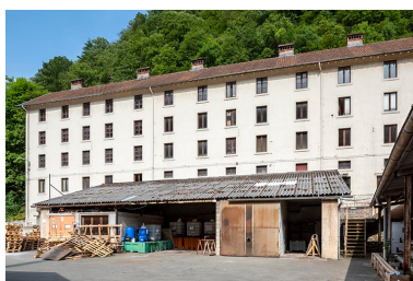
Bureau (façade postérieure) et entrepôt industriel.
