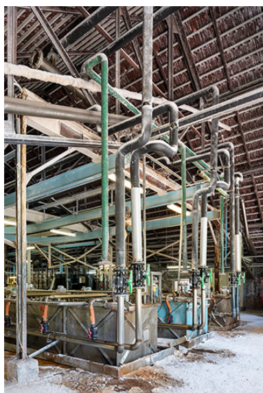
Fabrication : retraitement du sel (cristallisation).
