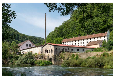
Vue d'ensemble rapprochée, depuis l'extrémité du barrage au nord-est.
