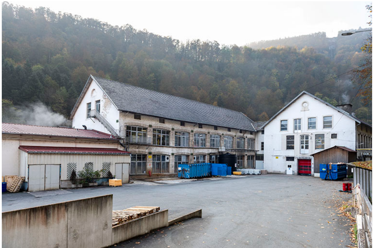
La cour depuis l'entrée : bâtiments des années 1968-1975 (à gauche) et 1897 (tréfilerie au centre et pointerie à droite).
