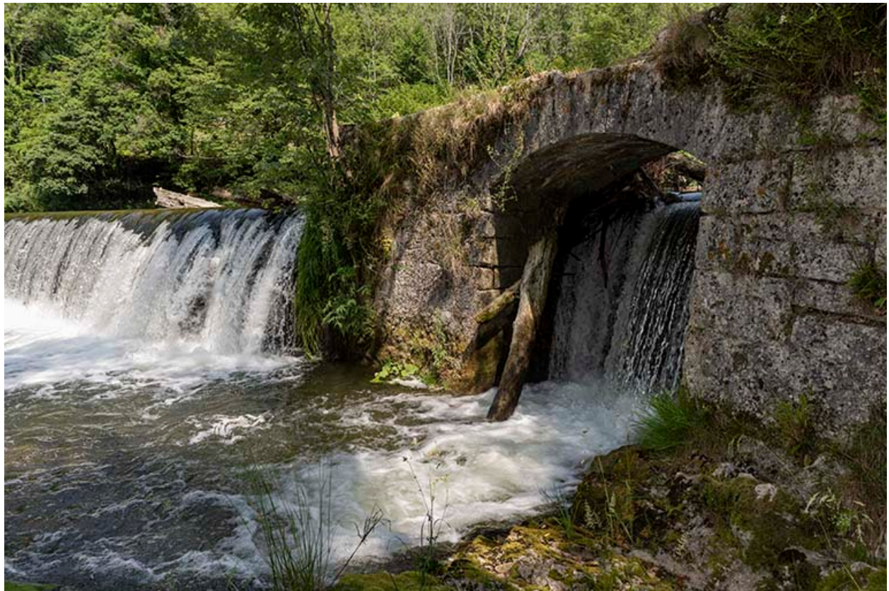
Extrémité du barrage rive droite.
