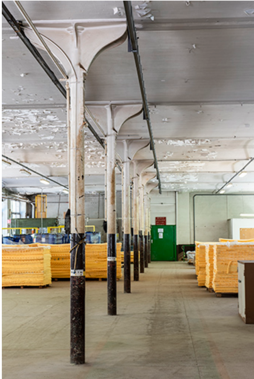
Atelier de fabrication (ancienne tréfilerie, 1er étage) : poteaux en fonte et voûtaines en briques plâtrées.
