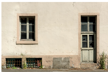
Bureau, façade antérieure : détail.
