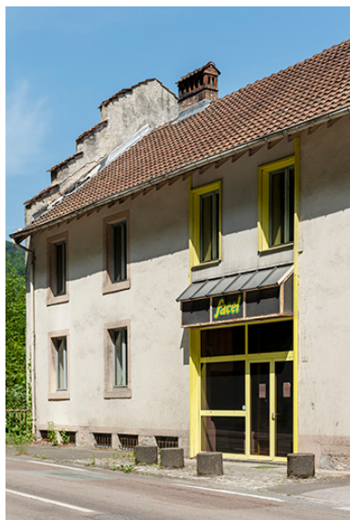
Bureau, façade antérieure : entrée.
