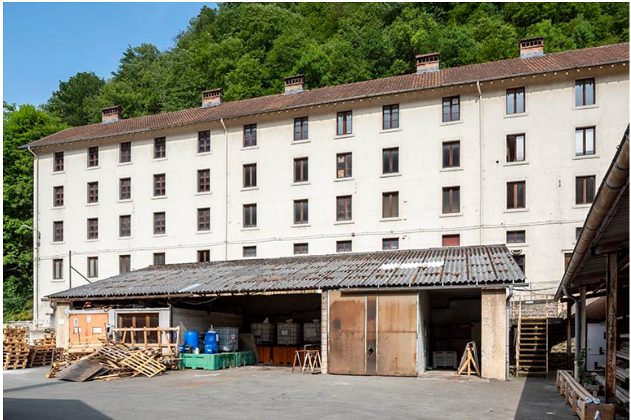
Bureau (façade postérieure) et entrepôt industriel.
