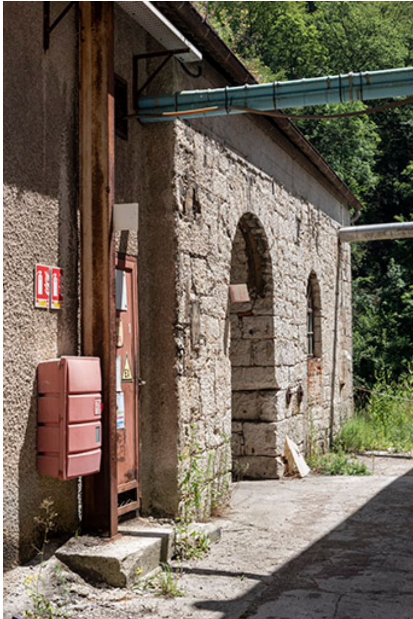
Bâtiment d'eau : façade antérieure, vue en enfilade.
