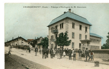
Charquemont (Doubs) - Fabrique d'horlogerie de M. Guillaume, 1912. Avant la construction du deuxième étage carré sur l'usine. Autr. auteur inconnu IVR43_20152500154NUC4A
