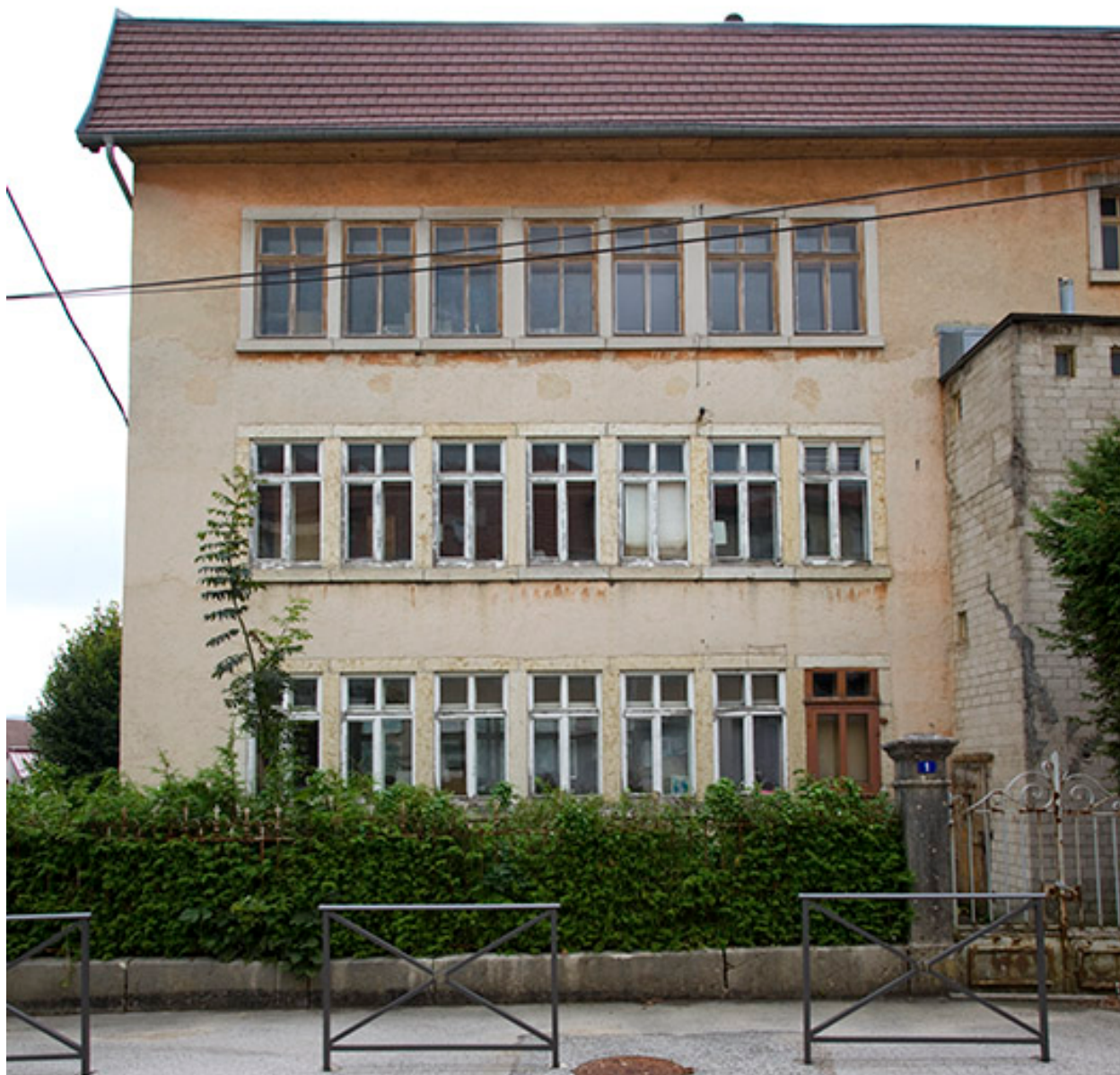
Usine : façade postérieure.
