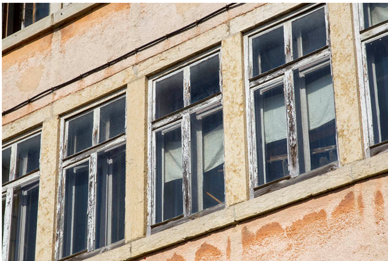
Usine, façade antérieure : détail des fenêtres multiples.
