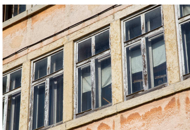
Usine, façade antérieure : détail des fenêtres multiples.
