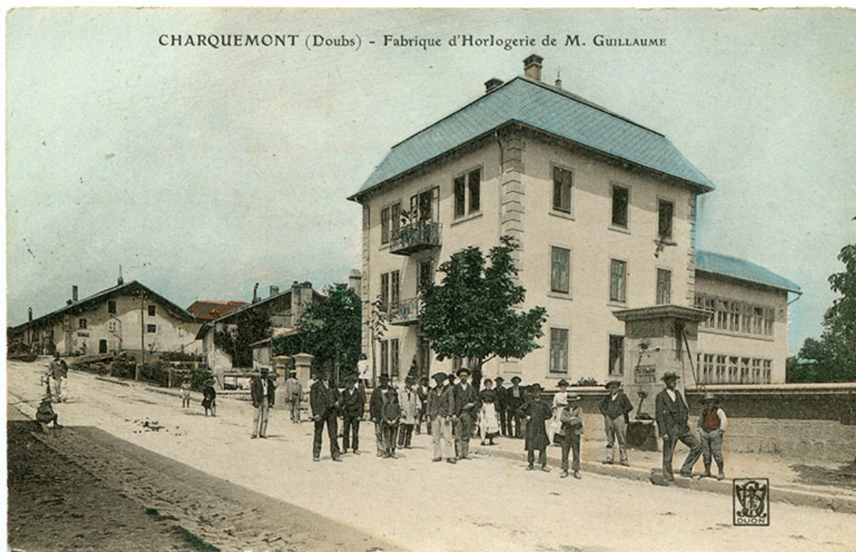
Charquemont (Doubs) - Fabrique d'horlogerie de M. Guillaume, 1912. Avant la construction du deuxième étage carré sur l'usine.
