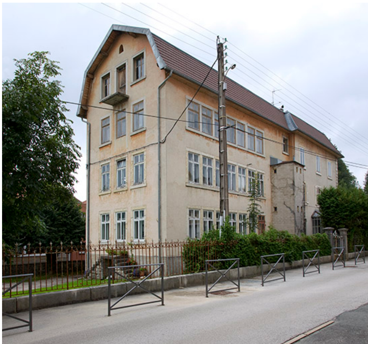
Usine : façades postérieure et latérale droite.
