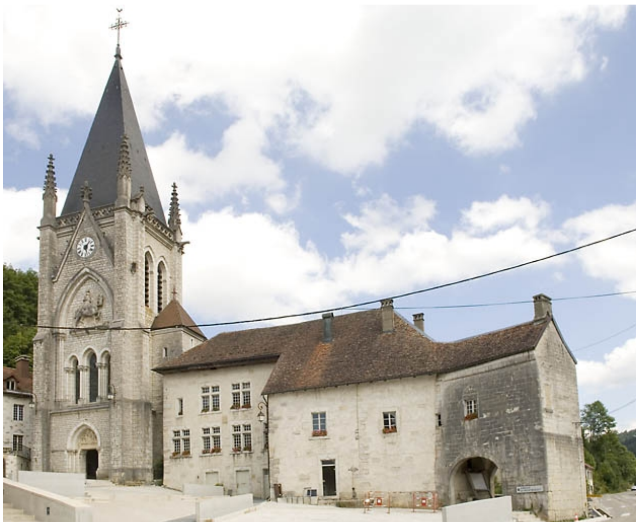
Vue d'ensemble des façades
