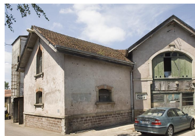
Aile ouest de l'atelier de saboterie (?). Phot. Jérôme Mongreville IVR43_20097000461NUC2A
