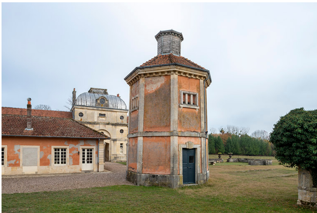
Pigeonnier, vue depuis le nord-ouest.
