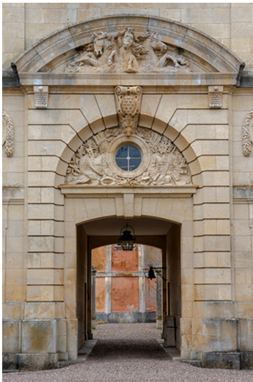
Portail à porte cochère du pavillon central.
