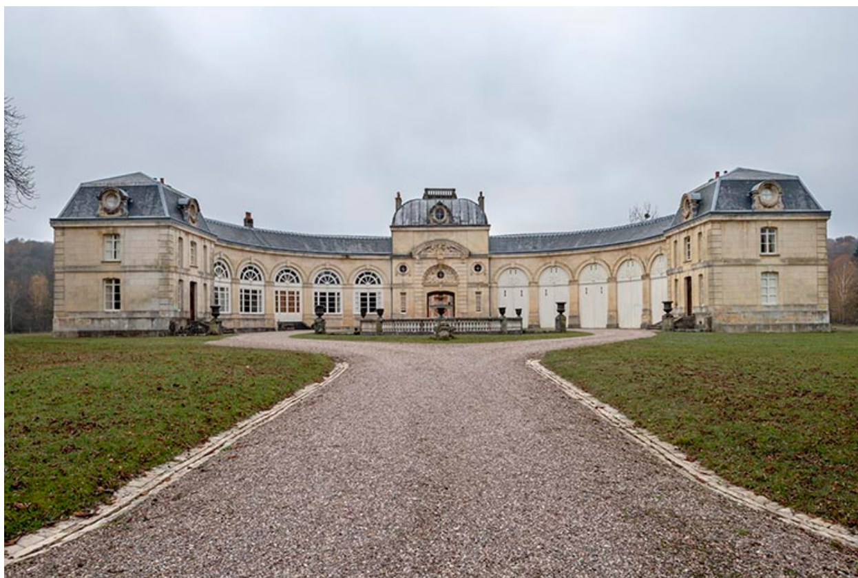
Façade orientale de l'écurie.
