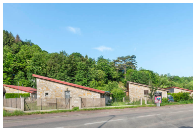
Vue d'ensemble depuis l'avenue Aristide Briand. Phot. Jérôme Mongreville IVR43_20243900694NUC4A
