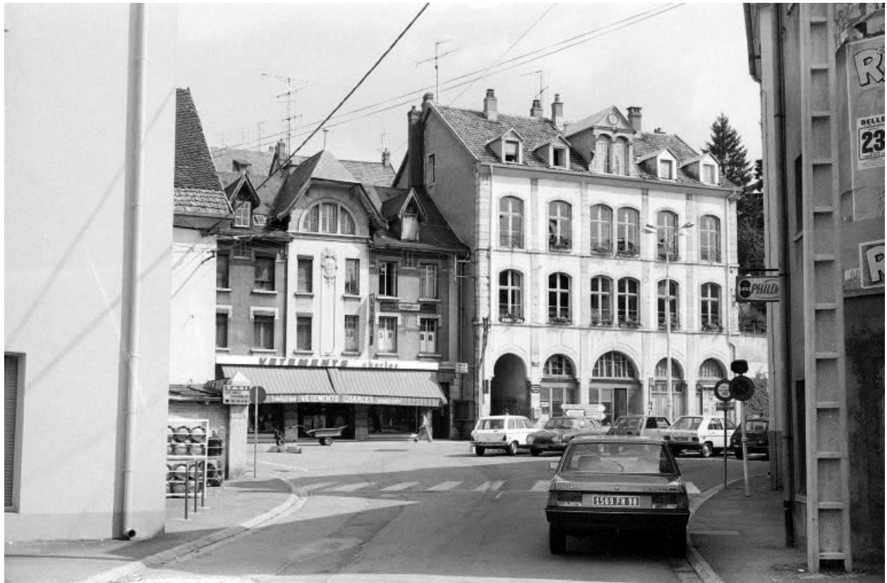
Ecole : façades antérieure et latérale droite.
