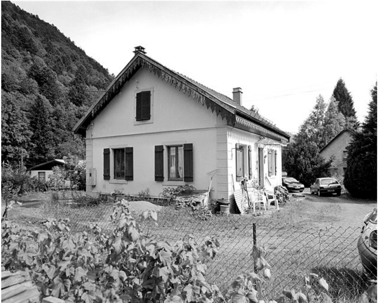
Logement de contremaître.
