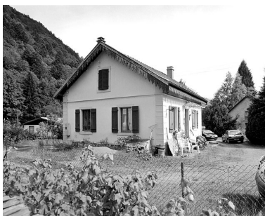
Logement de contremaître.
