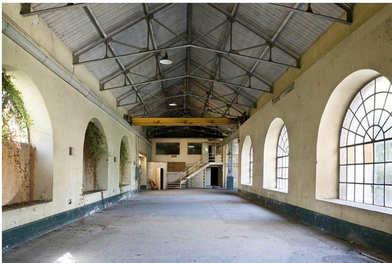
Vue intérieure de la salle des turbines.
