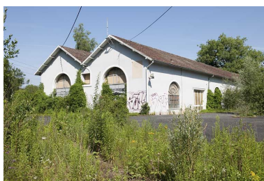
Vue d'ensemble depuis l'entrée.
