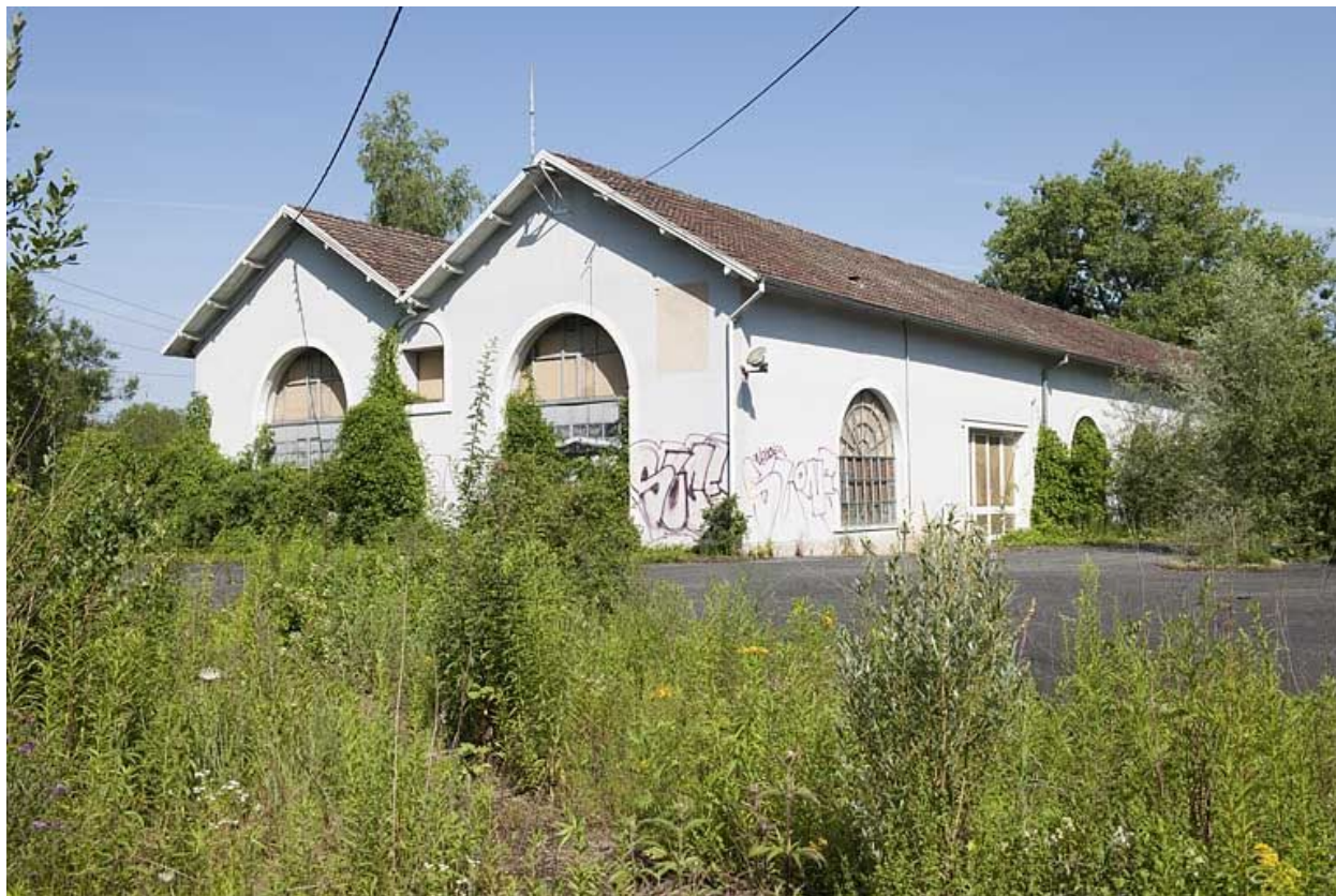
Vue d'ensemble depuis l'entrée.
