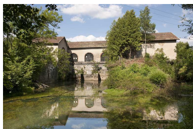
Vue d'ensemble depuis l'aval du bief.
