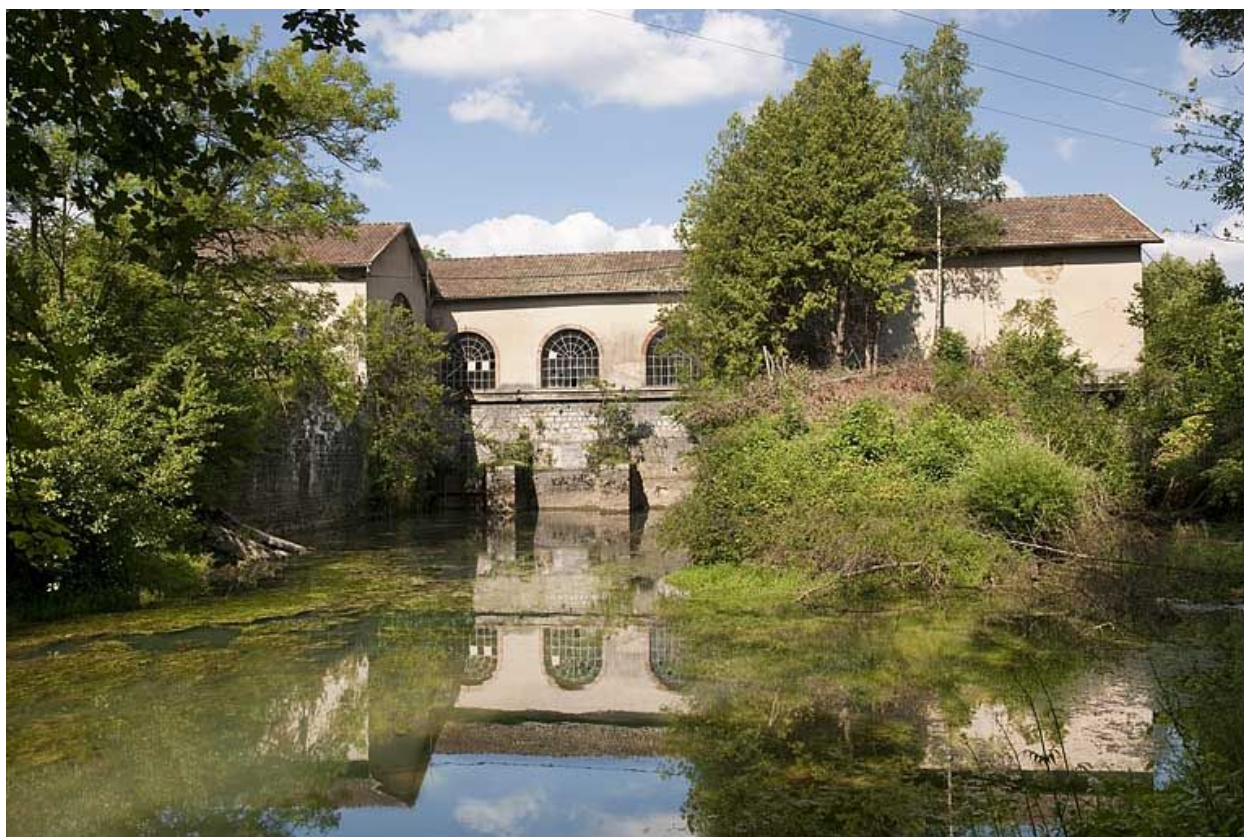
Vue d'ensemble depuis l'aval du bief.
