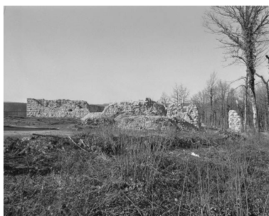
Vue générale du mur d'enceinte depuis l'est. Phot. Jérôme Mongreville IVR43_20002500010X
