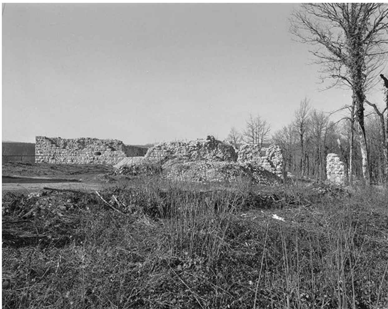
Vue générale du mur d'enceinte depuis l'est.
