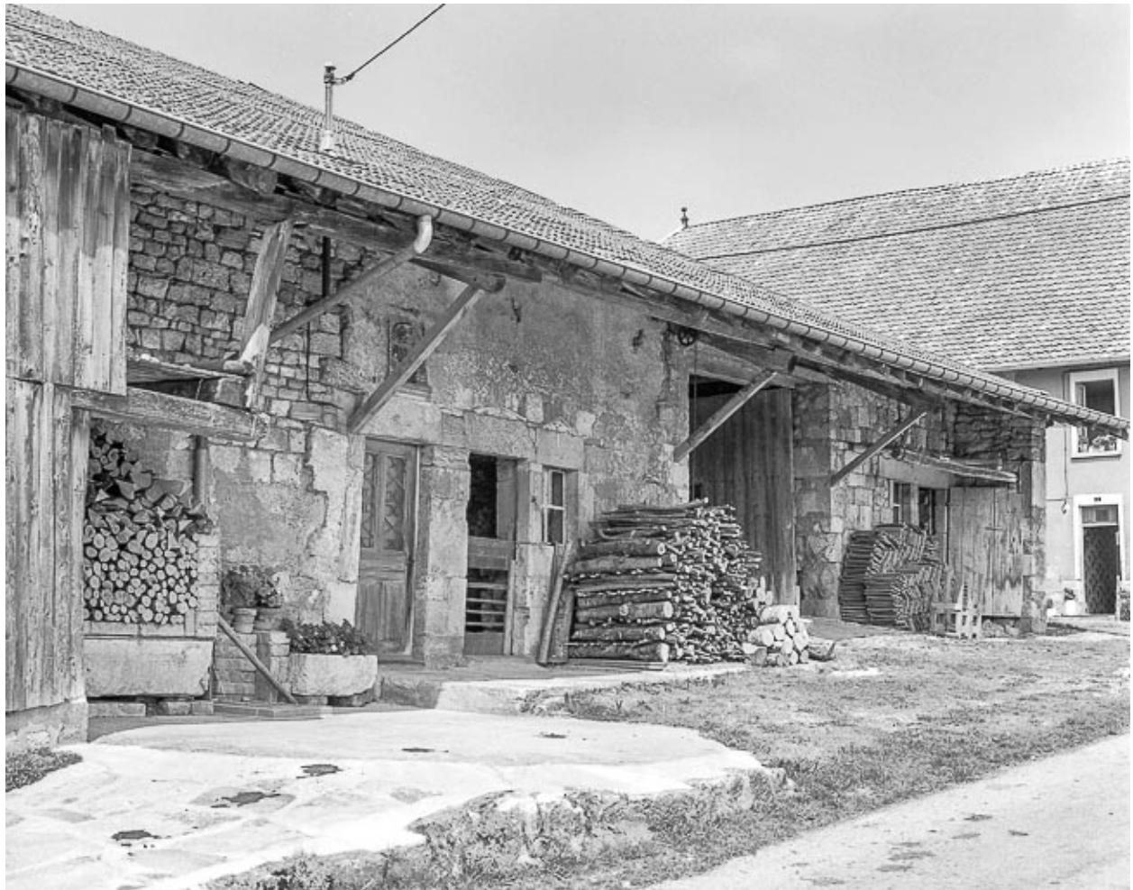
Ferme : goutterot sur rue.
