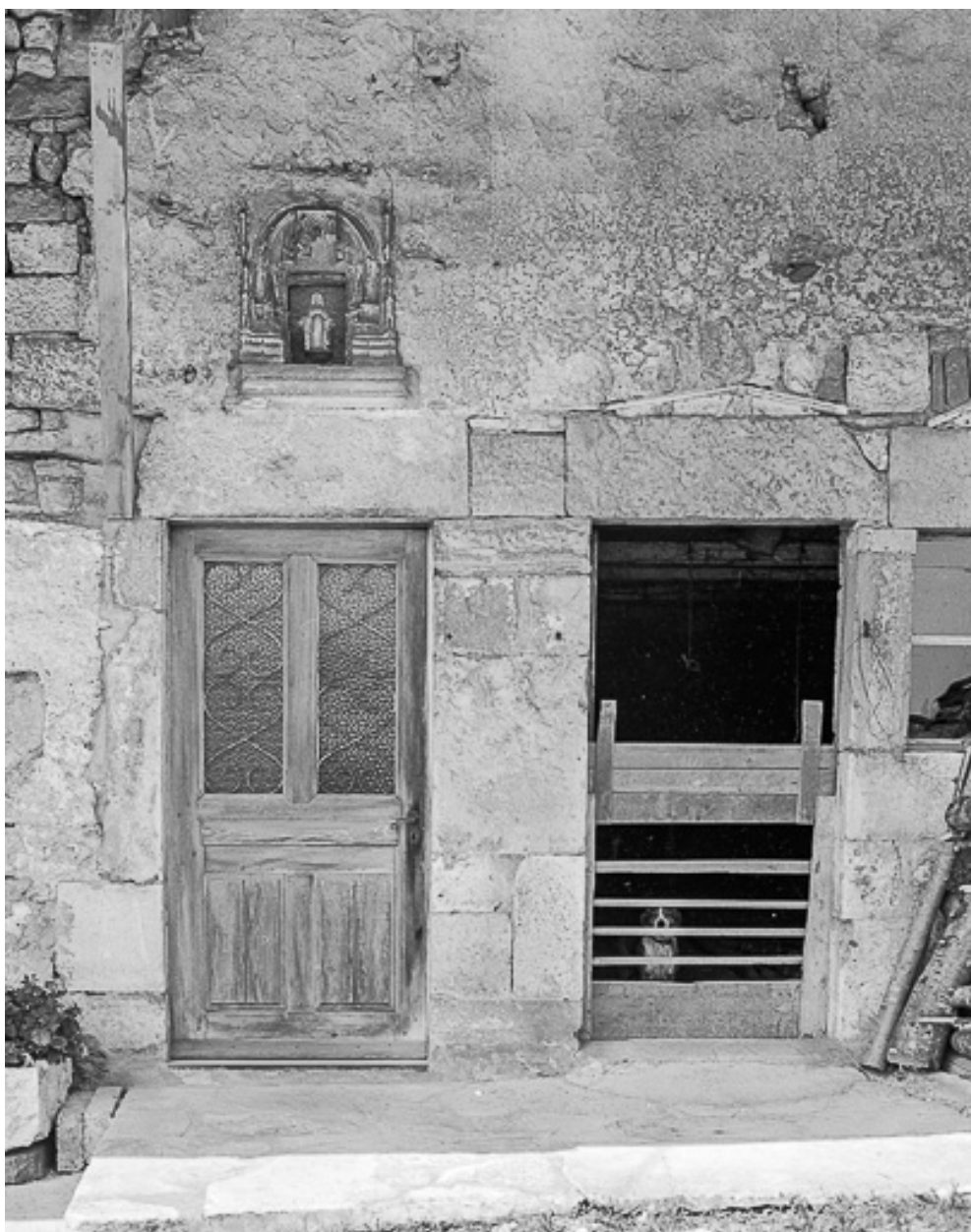
Ferme : détail des ouvertures sur rue.
