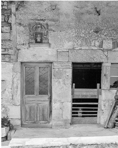
Ferme : détail des ouvertures sur rue.
