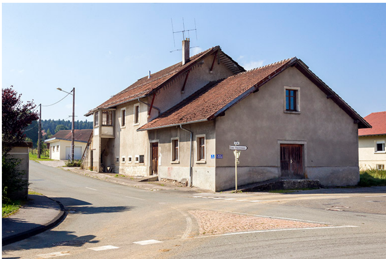
Façades postérieure et latérale droite.
