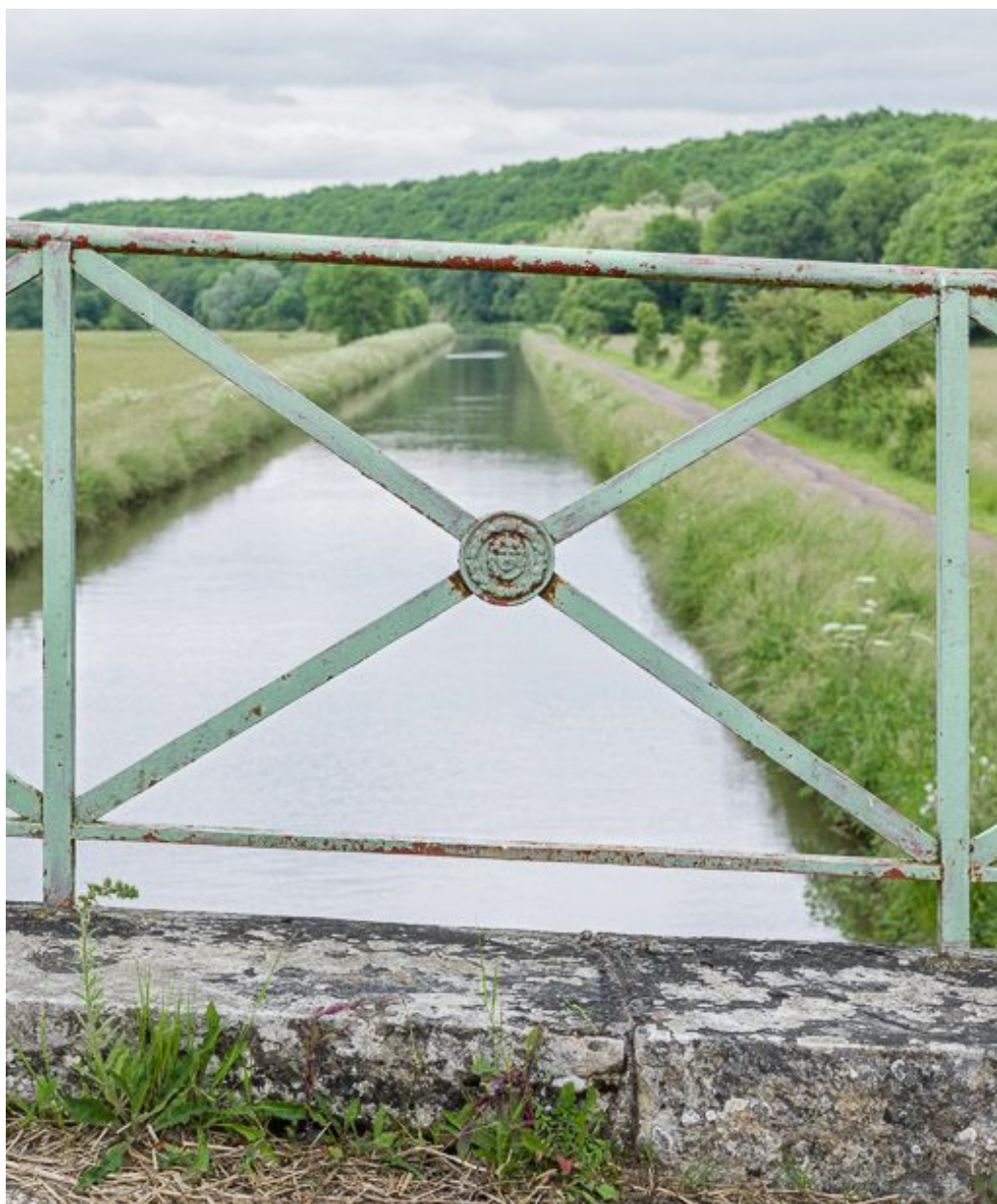
Détail du garde-corps.
