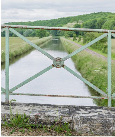
Détail du garde-corps.
